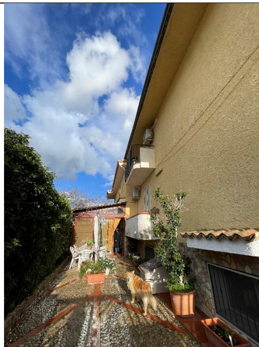
Cortile di ingresso su sub 3
