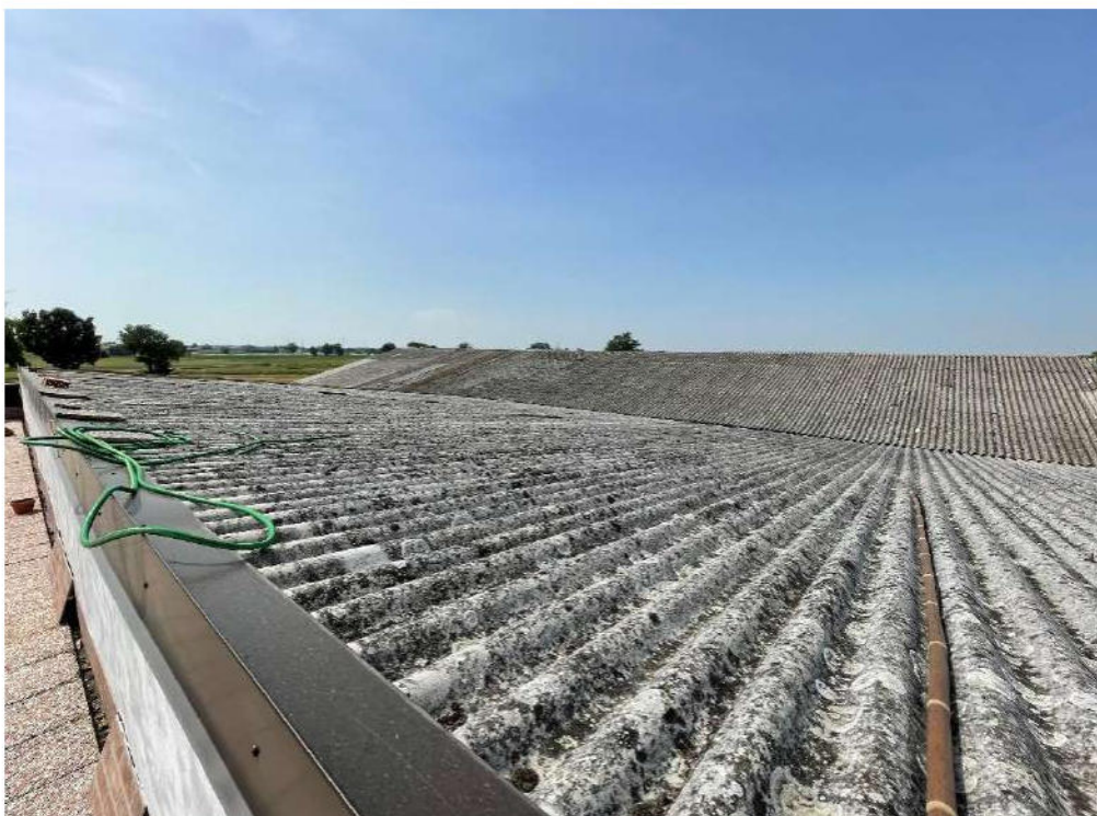
Dettaglio - Tetto del capannone artigianale - Sub.1 (foto 2)
