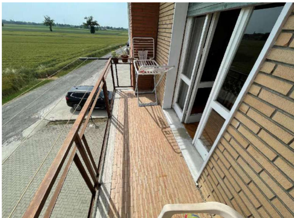
Piano Primo - Appartamento 1 (Sub.2) - Balcone
