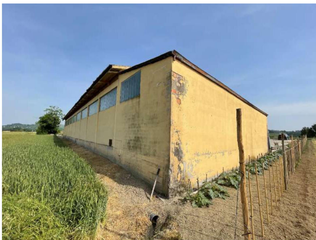
Fabbricato - Vista da area agricola (foto 1)
