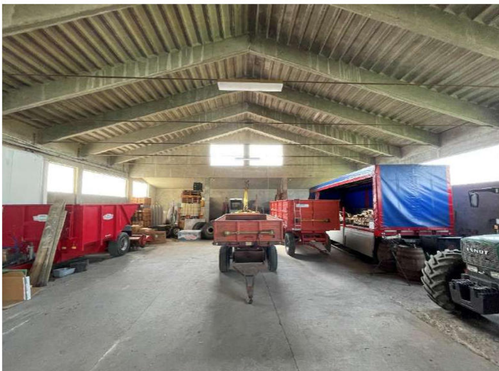
Piano Terra - Capannone artigianale - Sub.4 (foto 6)
