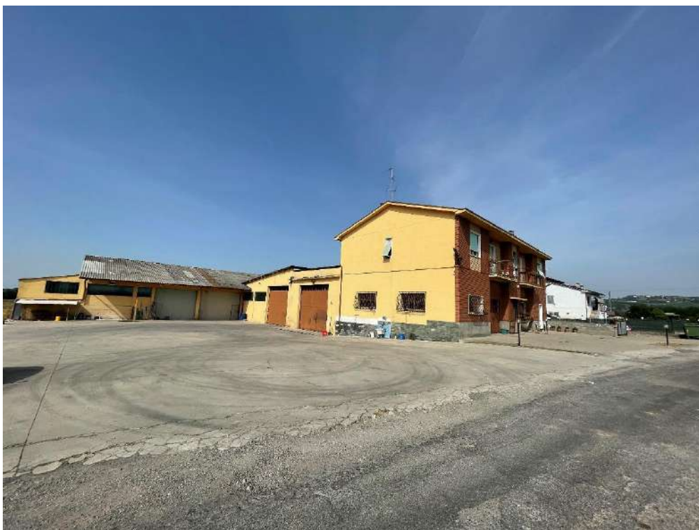
Fabbricato - Vista dalla Strada Provinciale (foto 1)
