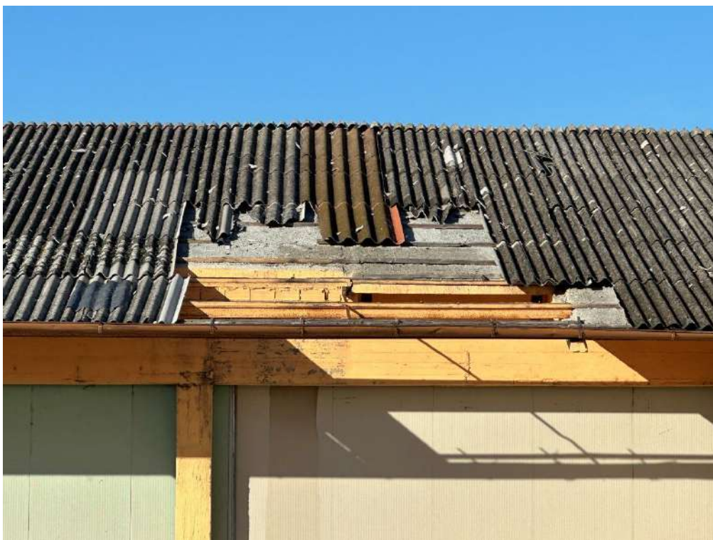
Dettaglio - Tetto del capannone artigianale - Sub.4 (foto 4)
