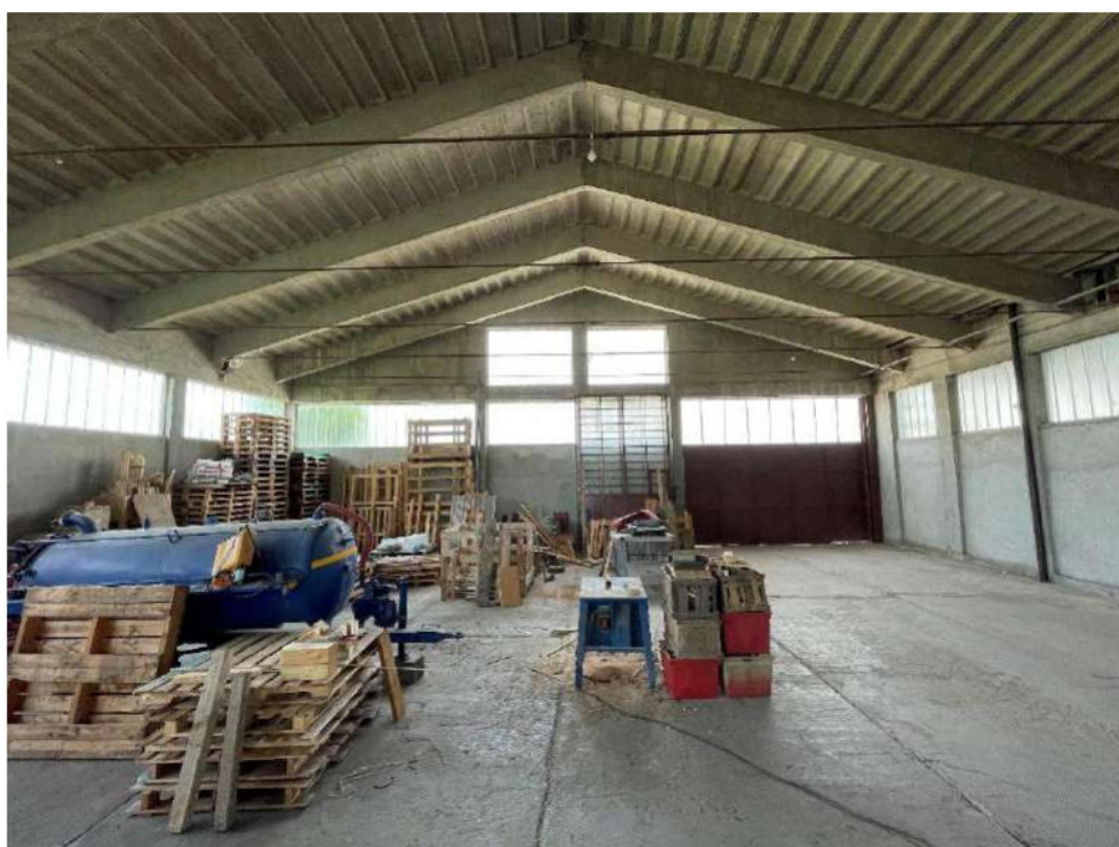
Piano Terra - Capannone artigianale - Sub.4 (foto 3)
