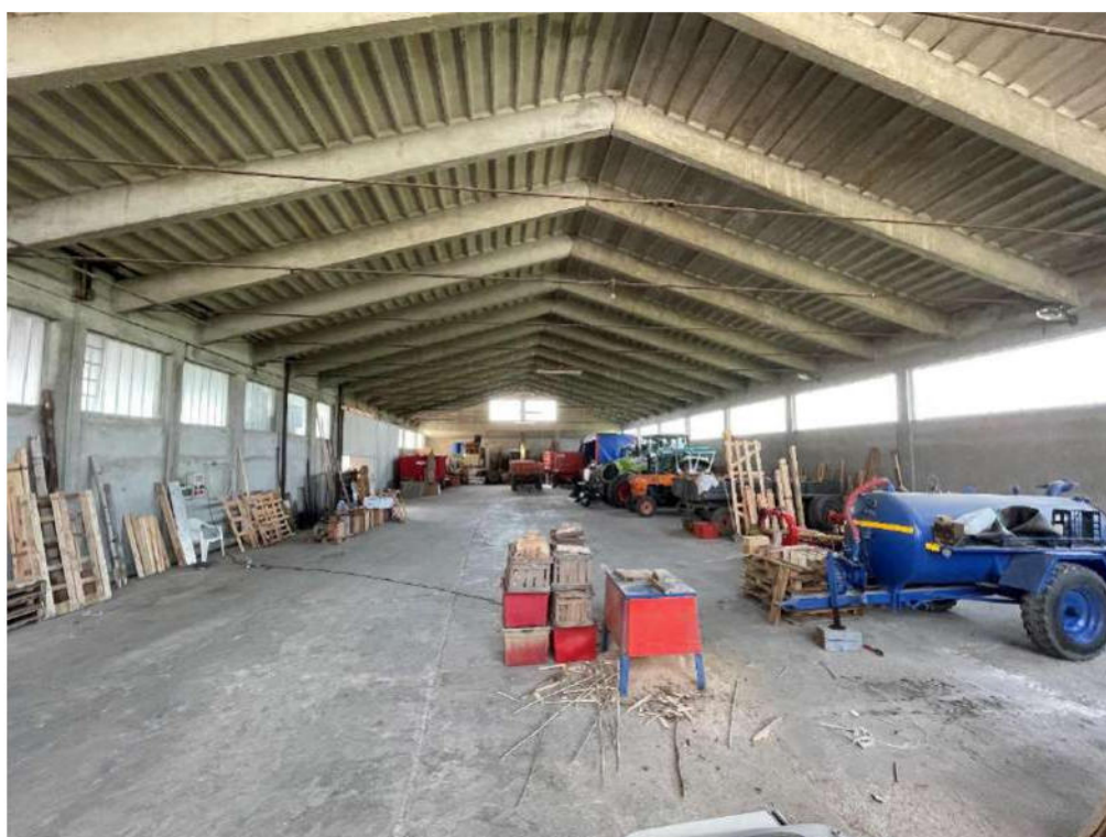
Piano Terra - Capannone artigianale - Sub.4 (foto 5)
