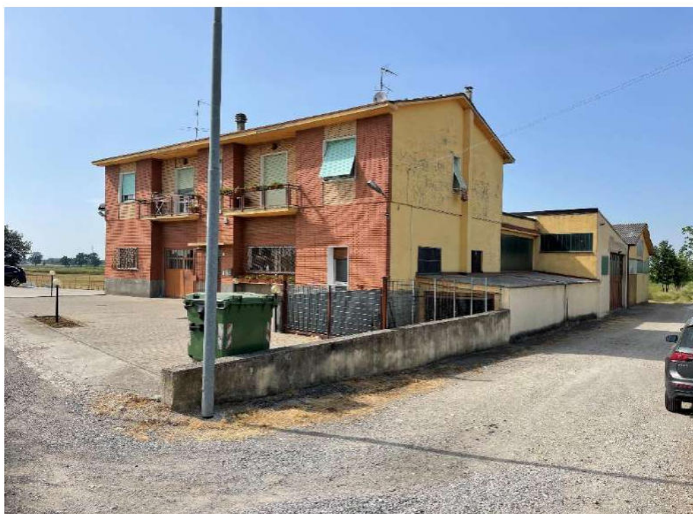
Fabbricato - Vista dalla Strada Provinciale (foto 2)
