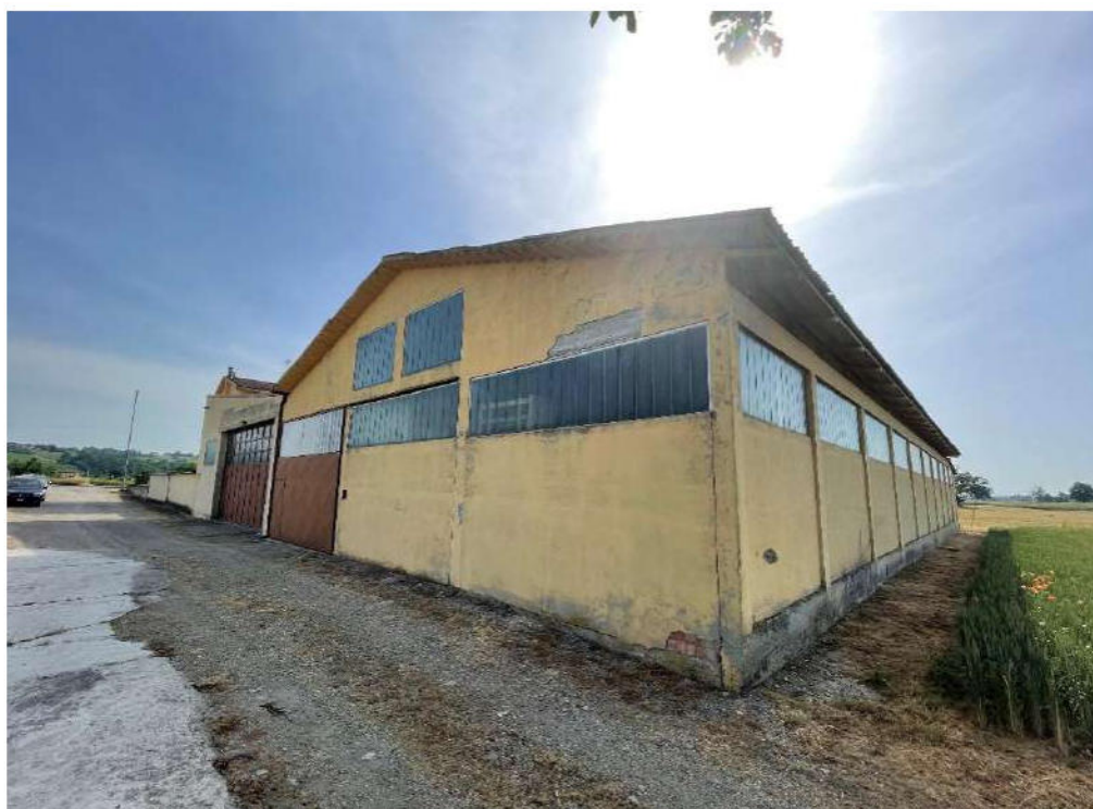
Fabbricato - Vista dalla strada vicinale (foto 2)
