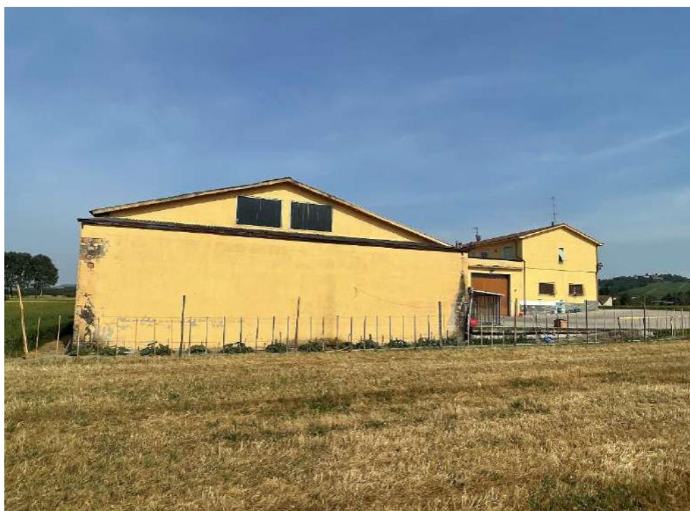
Fabbricato - Vista da area agricola (foto 2)
