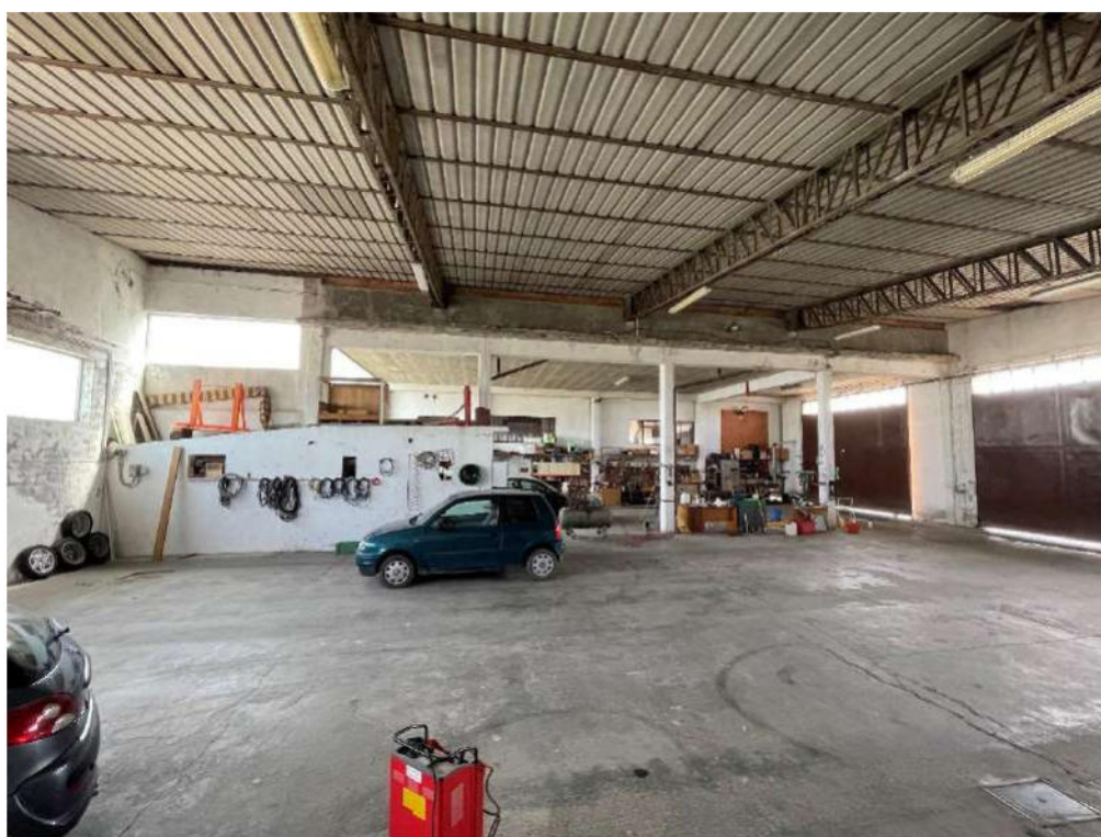
Piano Terra - Capannone artigianale - Sub.1 (foto 5)
