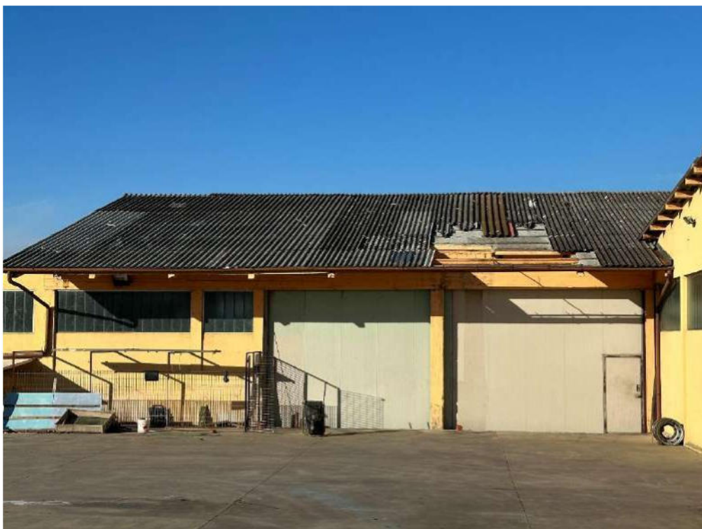
Dettaglio - Tetto del capannone artigianale - Sub.4 (foto 3)
