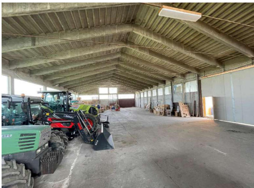
Piano Terra - Capannone artigianale - Sub.4 (foto 2)
