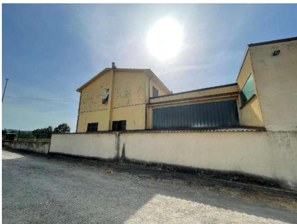
Fabbricato - Vista dalla strada vicinale (foto 1)
