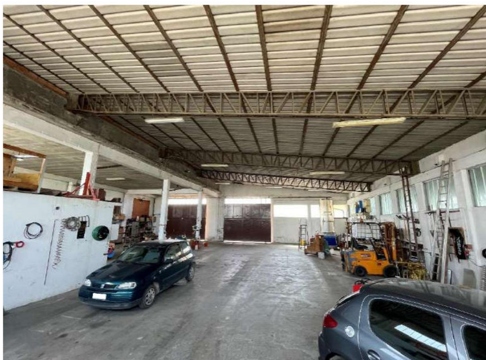
Piano Terra - Capannone artigianale - Sub.1 (foto 4)
