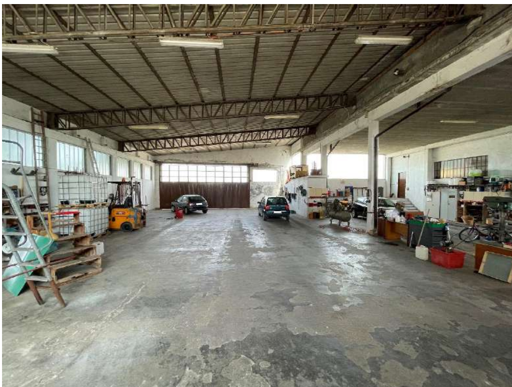
Piano Terra - Capannone artigianale - Sub.1 (foto 1)
