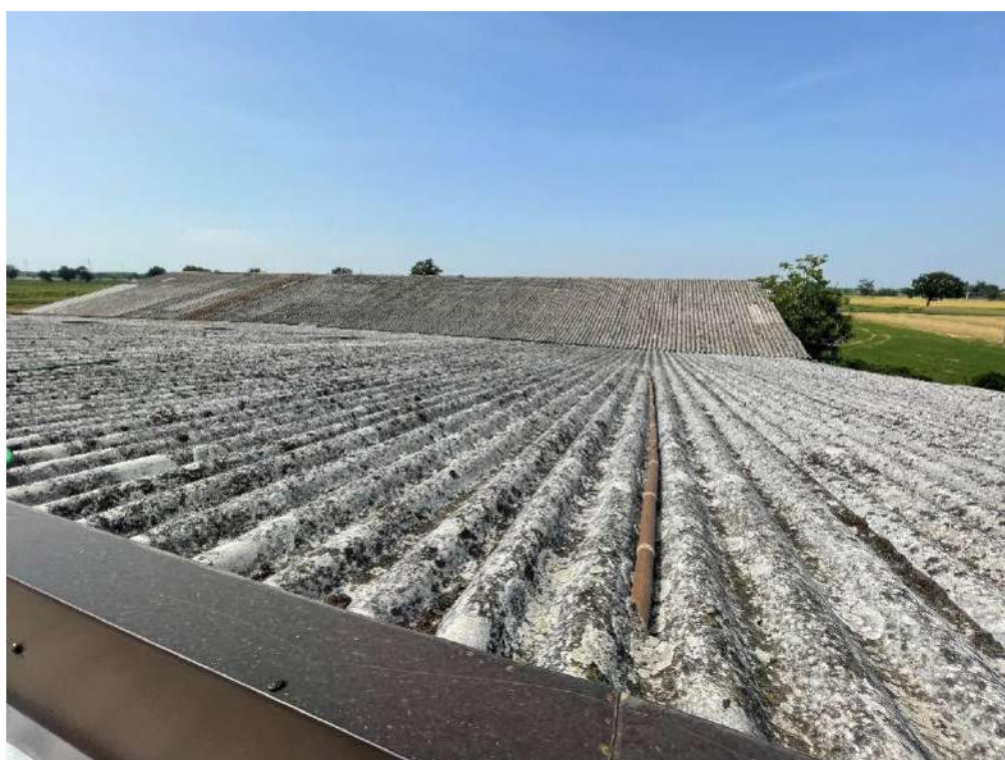
Dettaglio - Tetto del capannone artigianale - Sub.1 (foto 1)
