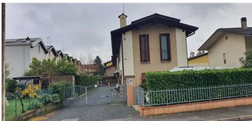
Ingresso alla viabilità comune
