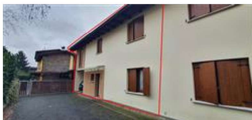
Edificio pignorato - Fronte
