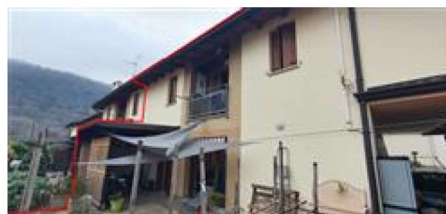
Edificio pignorato - Retro
