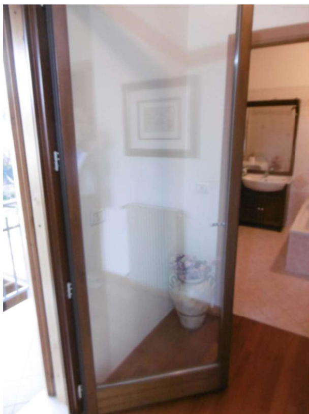
Interno alloggio – Serramento
