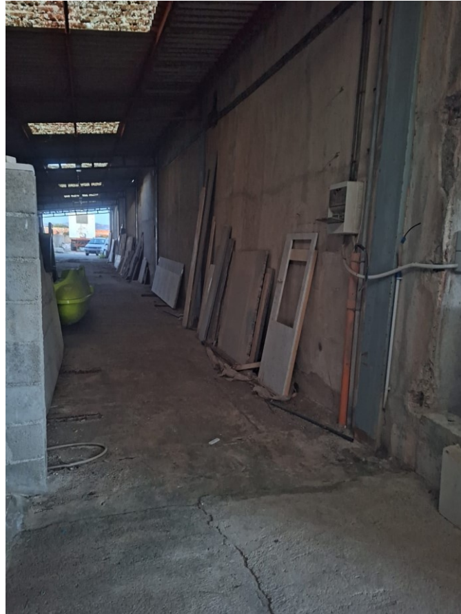
Foto 25 , 26 – TETTOIA ingresso al capannone lato destro
