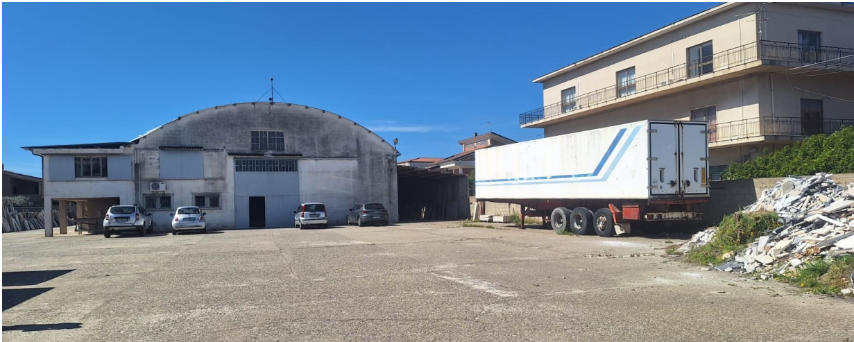
Foto 1 – 2 Prospetto su via delle Industrie- accesso all' attività – SUB 1
