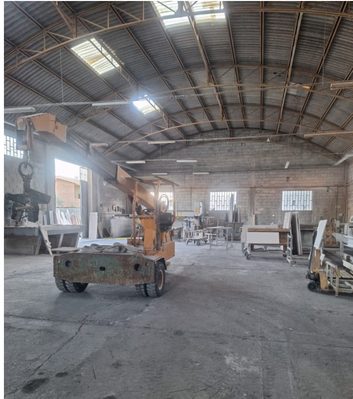
Foto 3 e 4 – Ingresso al capannone
