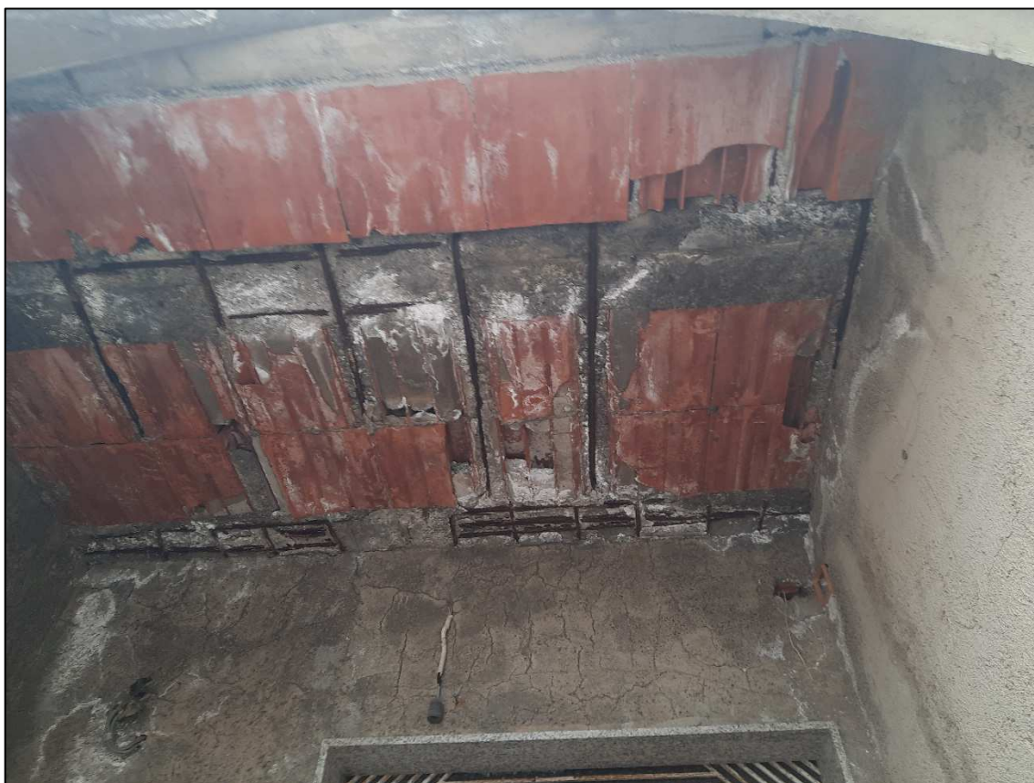
Solaio in corrispondenza del portico , accesso da via Martiri d'Ungheria n. 56
