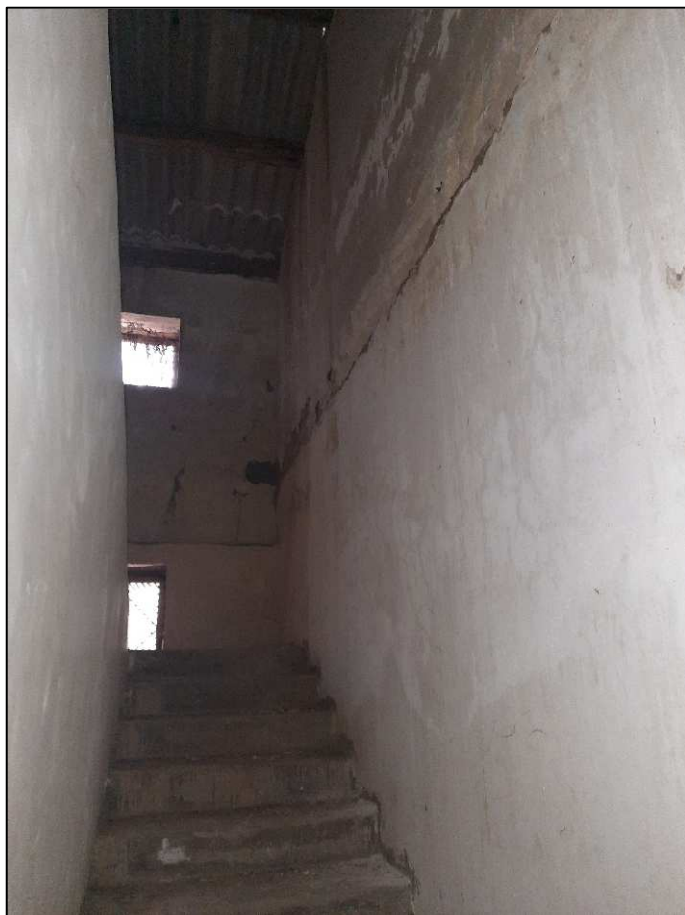
Scale accesso copertura
