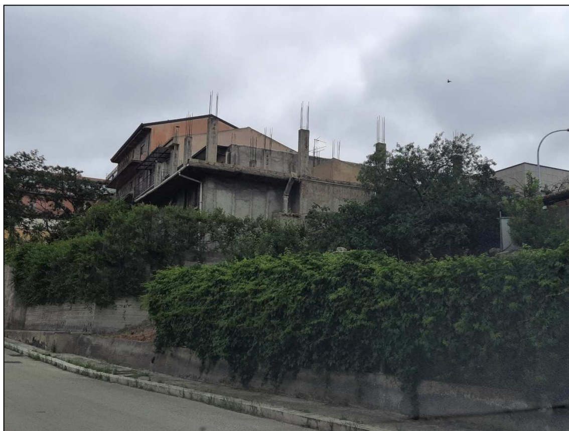
Esterno sub 3 e sub 4
