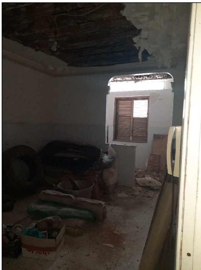
Vano 1 con Vano 2 con apertura finestrata
