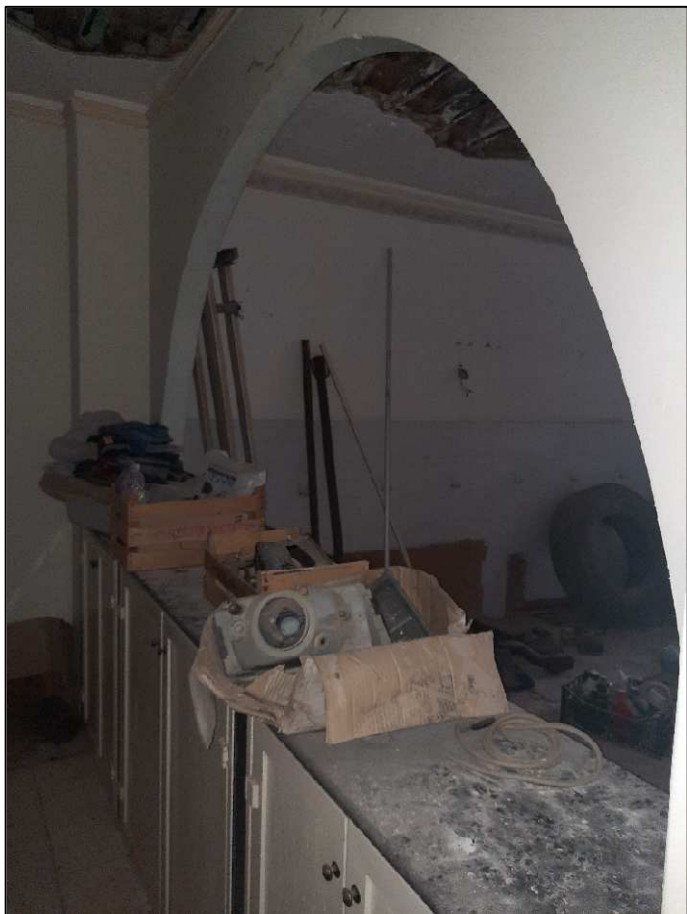
Arco tra vano 1 e 3
