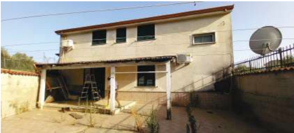
Figura 18: vista del prospetto posteriore del cespite con la veranda sul retro
