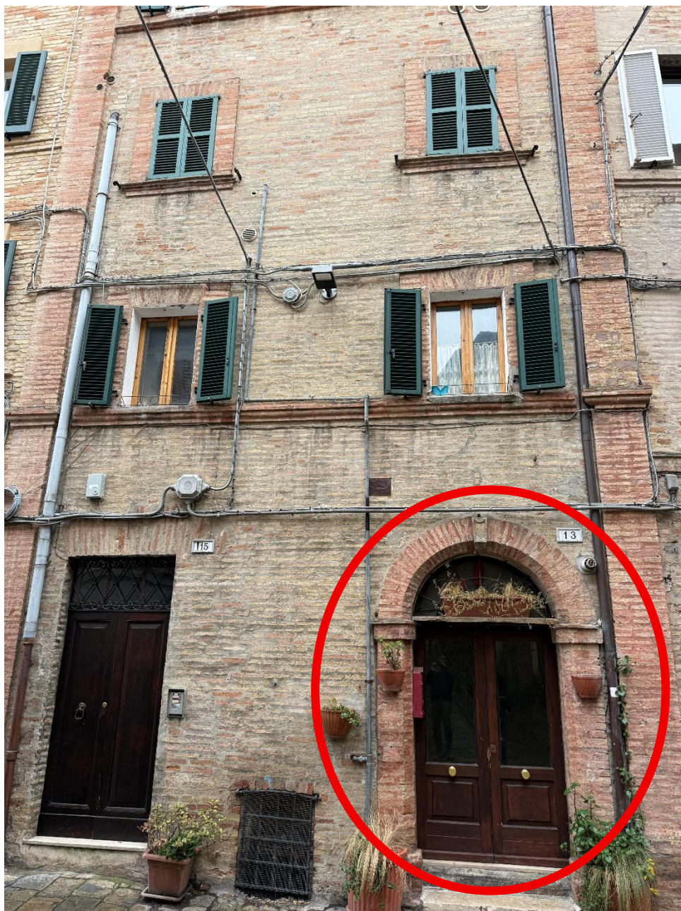
ESTERNO FABBRICATO CON INDIVIDUAZIONE PORTA INGRESSO APPARTAMENTO
