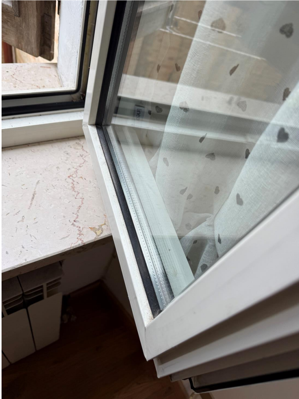
CAMERA 1 – PARTICOLARE FINESTRA (FOTO 3)
