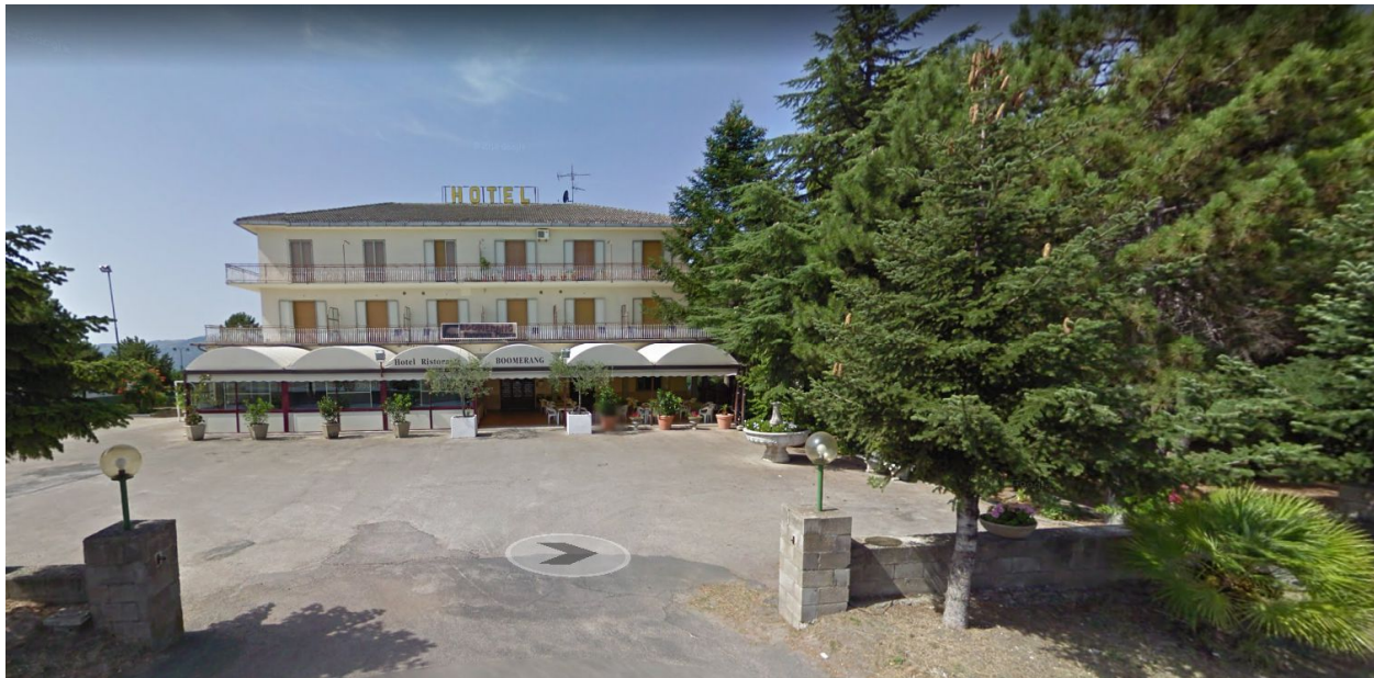
PRIMA DELLA RISTRUTTURAZIONE
