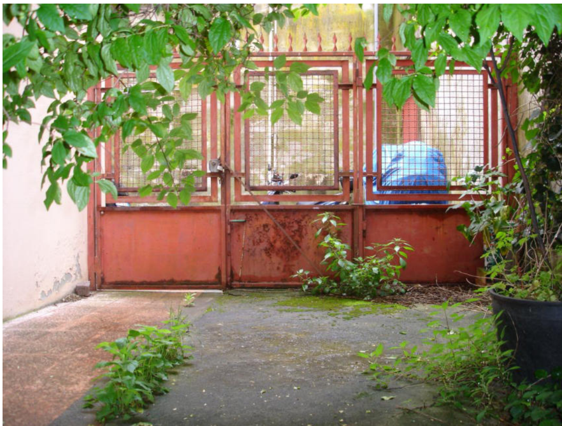
Vista accesso carrabile (dall'interno)
