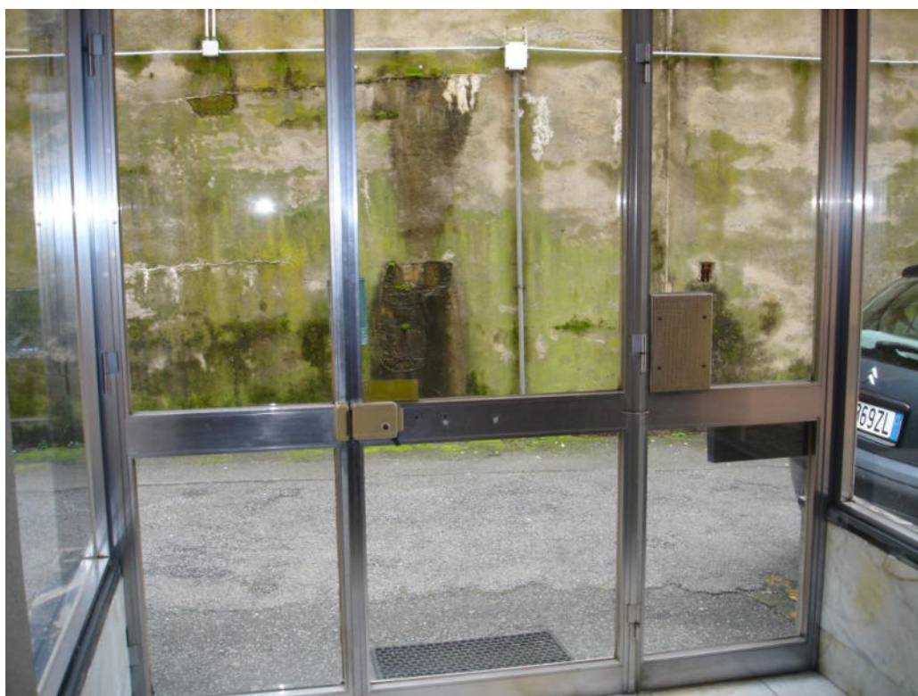
Portone di ingresso – vista dall'interno
