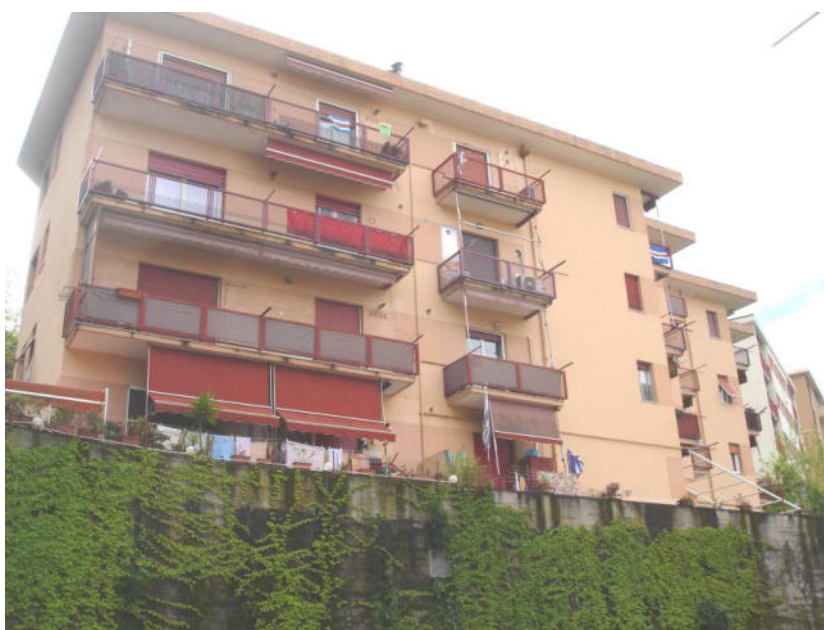
Prospetto Nord (vista dalla sottostante Via Antonio Sant'Elia)
