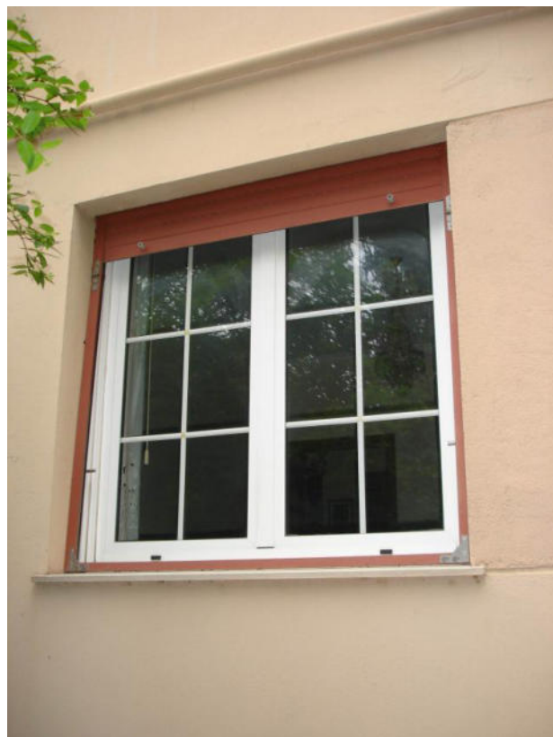
Particolare finestra camera da letto matrimoniale
