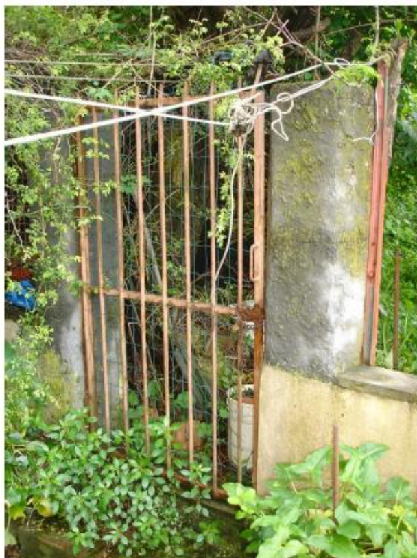
Cancello di accesso al terreno oggetto di accertamento
