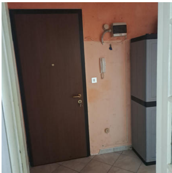
Foto 13 – Porta d'ingresso all'abitazione
