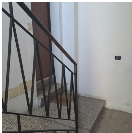
Foto 14 – Pianerottolo d' accesso all'abitazione
