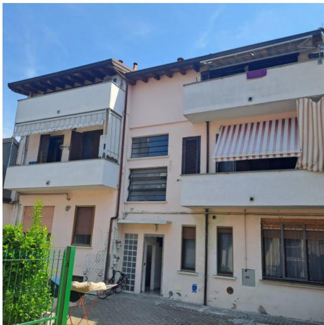
Foto 3 -Lato ovest del condominio dalla corte comune
