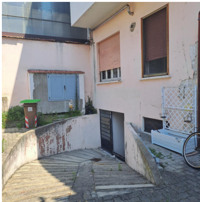
Foto 4 - Accesso alle cantine del piano interrato
