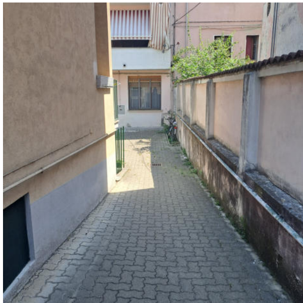
Foto 2 - Cortile comune di accesso
