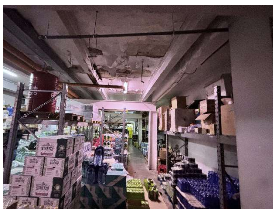
Foto n. 12 – Solaio sottostante piazzale pt
