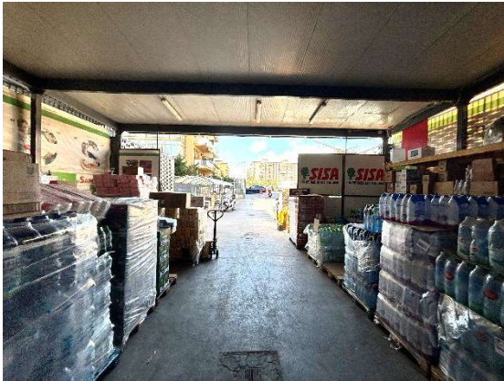
Foto n. 21 – Tettoia su retro
