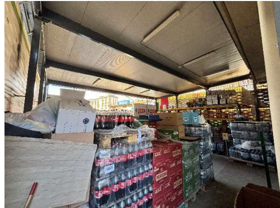
Foto n. 22 – Tettoia su retro
