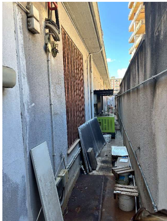
Foto n. 4 – Botola scala di uscita lato nord
