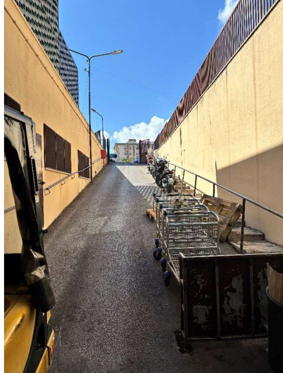
Foto n. 2 – Rampa d'accesso magazzino
