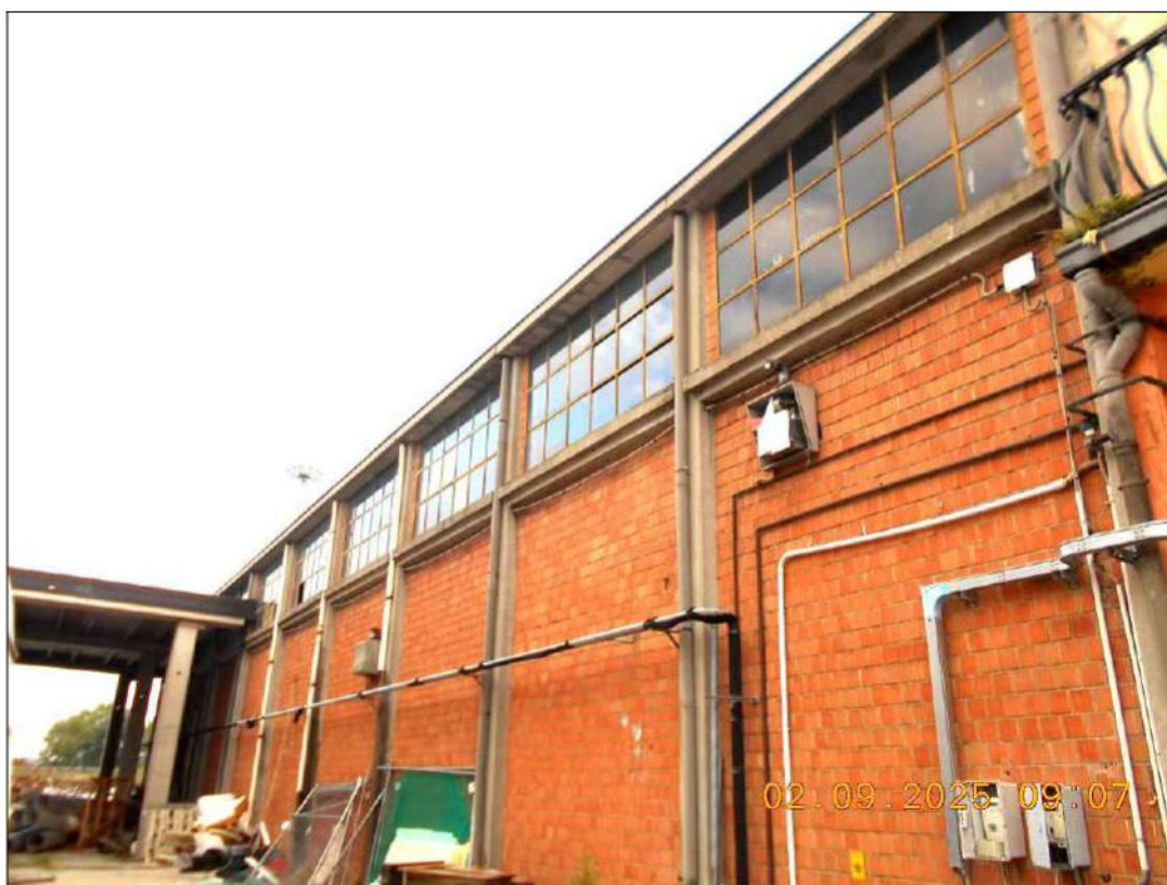
Figura 16 – vista esterna del fronte Sud del deposito – magazzino con particolari costruttivi
