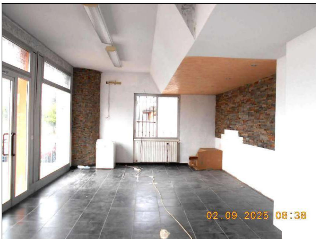
Figura 30 – vista interna dei particolari costruttivi dei locali al piano rialzato
