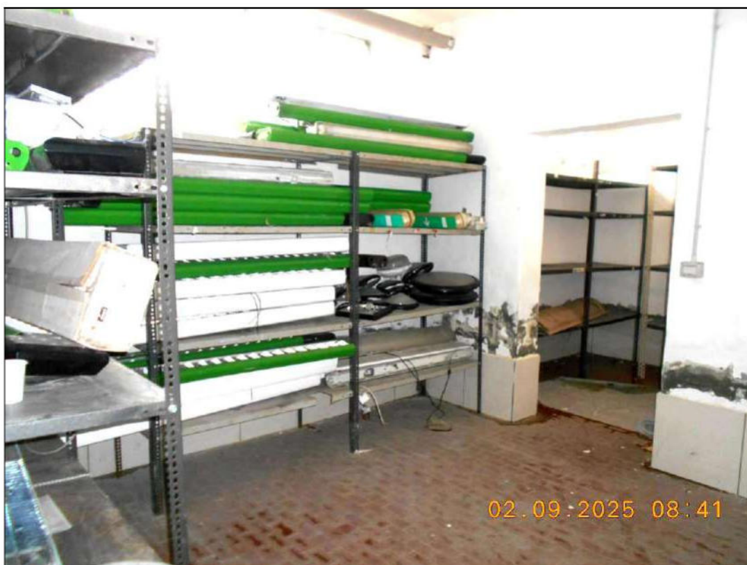
Figura 38 – vista interna dei particolari costruttivi dei locali al piano seminterrato
