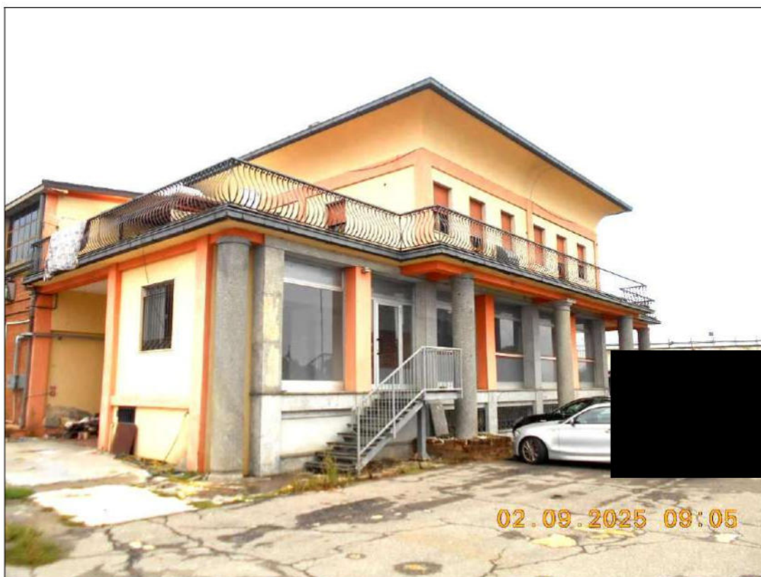
Figura 15 – vista esterna del fronte Est del complesso immobiliare
