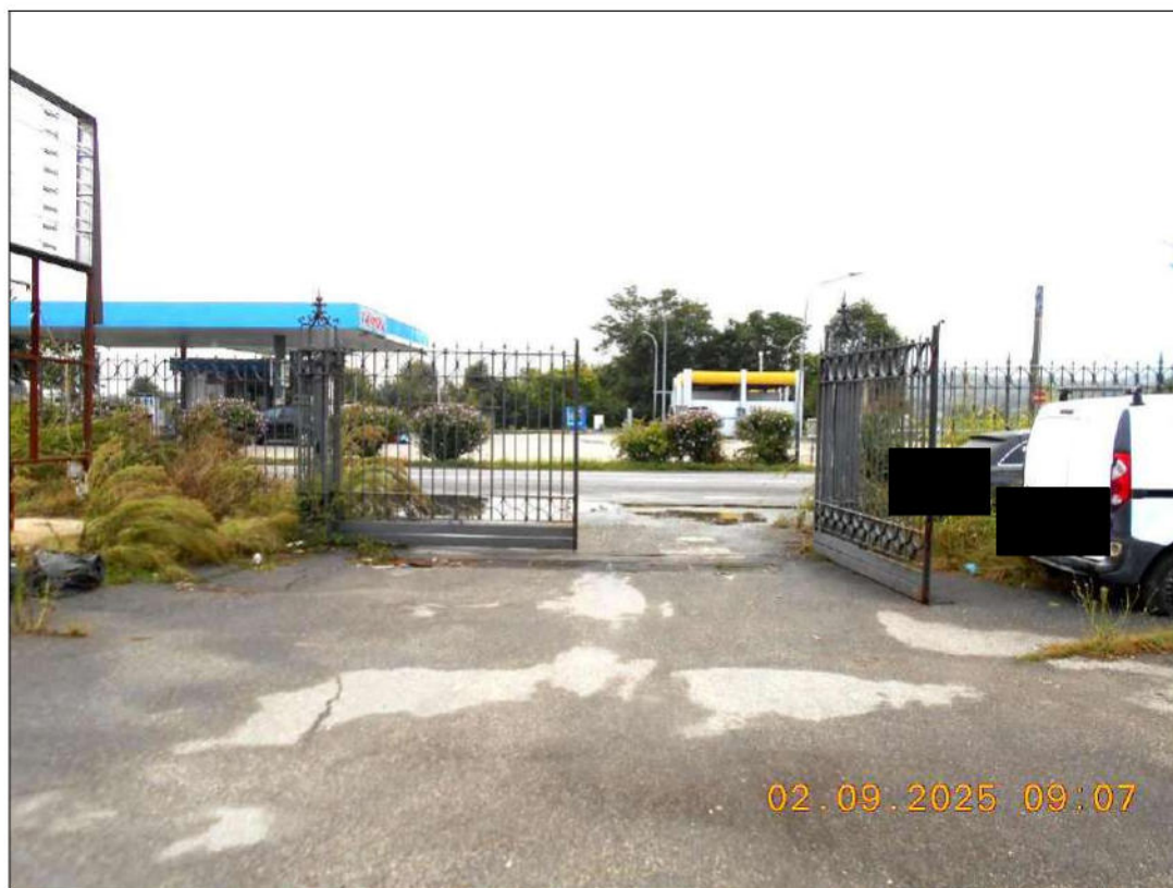
Figura 5 – vista esterna dell'ingresso carraio e pedonale dal piazzale comune
