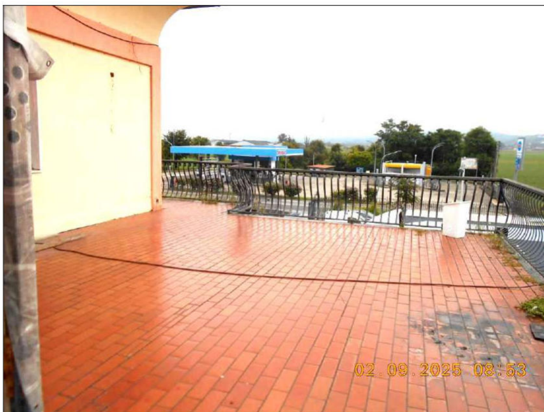
Figura 55 – vista esterna del terrazzo al piano primo
