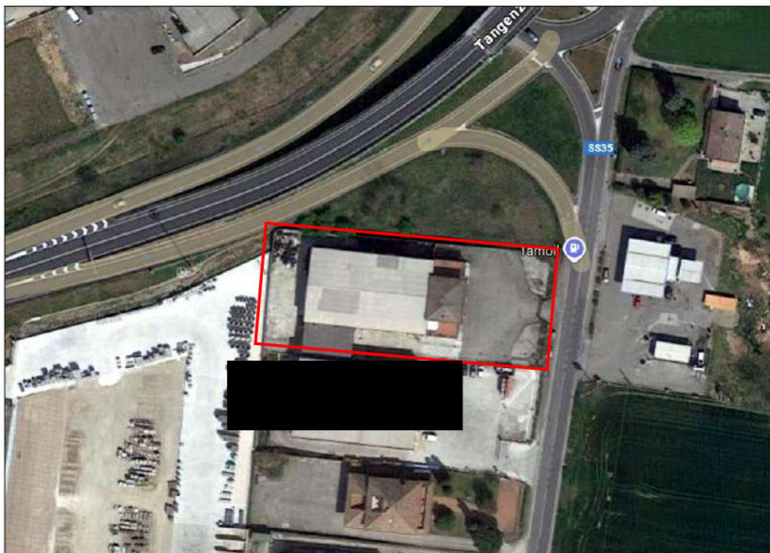
Figura 1 – vista aerea del complesso immobiliare
