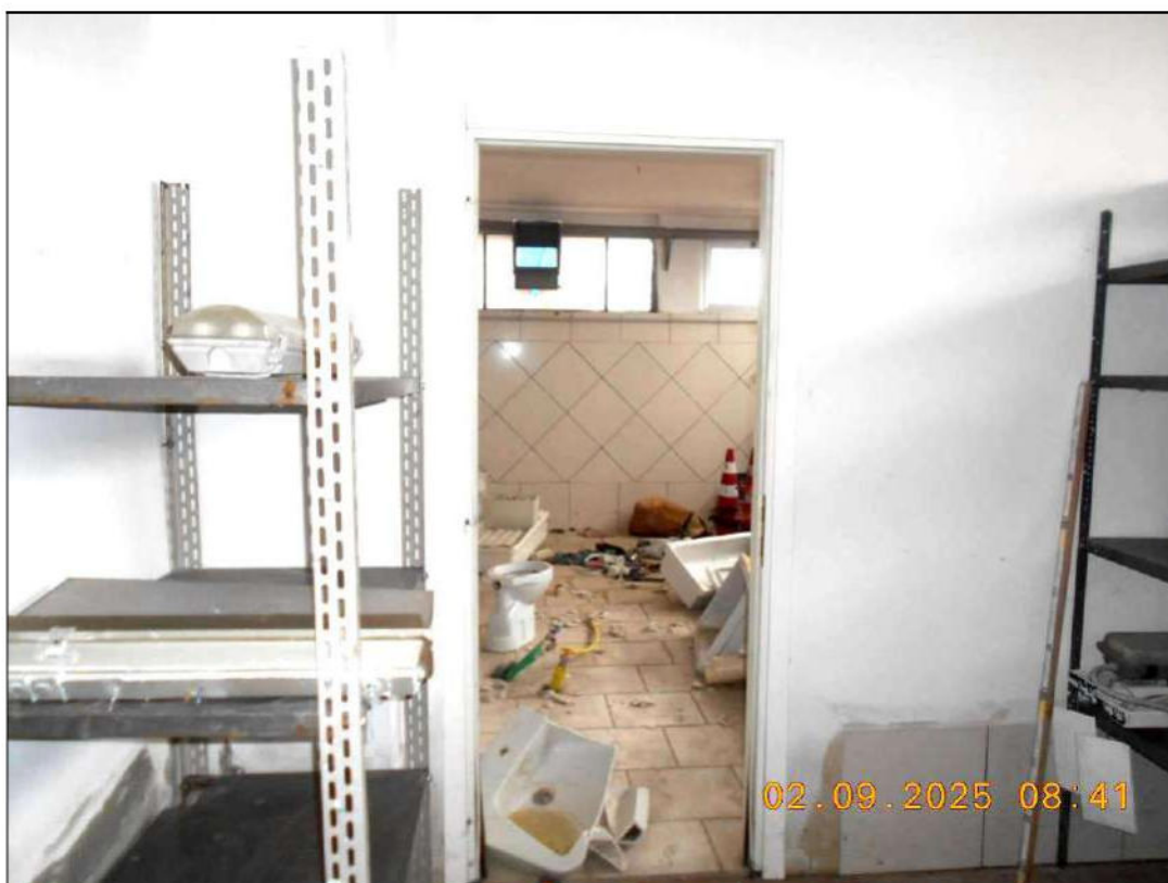
Figura 40 – vista interna dei particolari costruttivi dei locali al piano seminterrato
