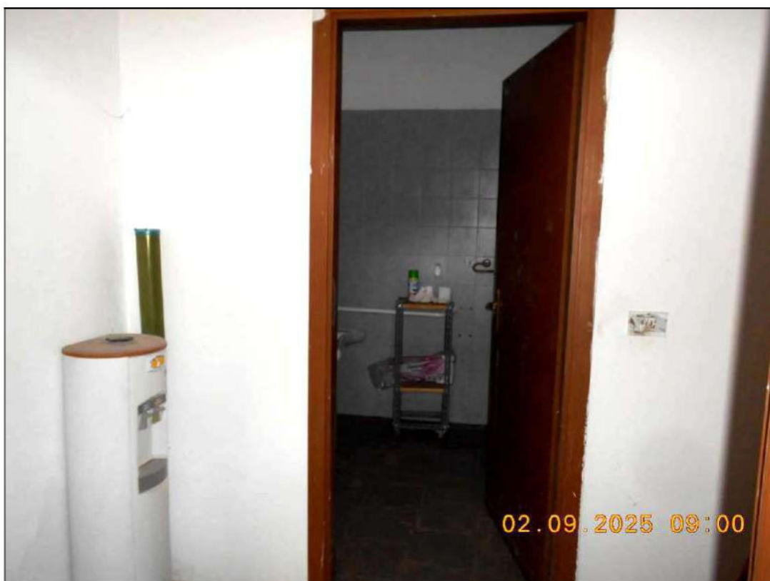
Figura 28 – vista interna del servizio igienico del deposito – magazzino al piano terra
