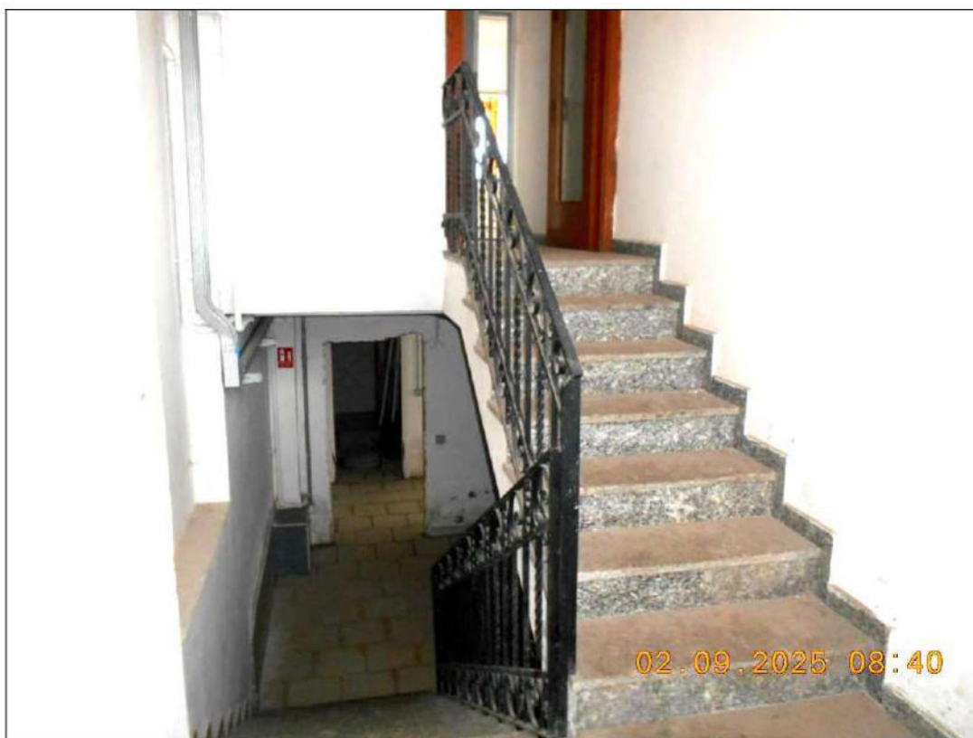
Figura 35 – vista interna della scala di collegamento tra i vari livelli
