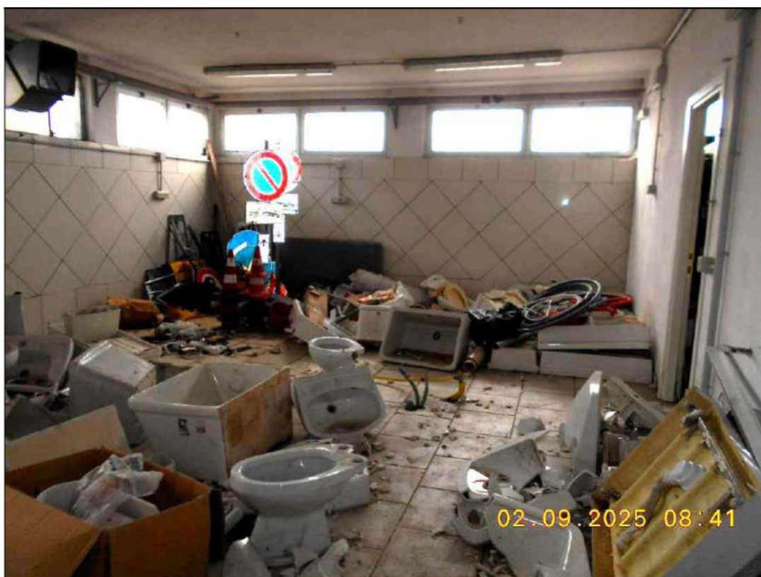
Figura 36 – vista interna dei particolari costruttivi dei locali al piano seminterrato
