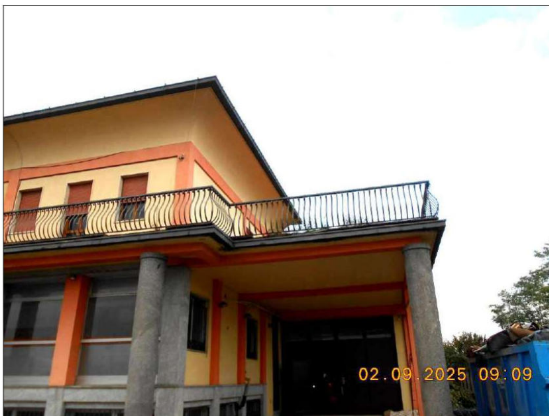
Figura 8 – vista esterna di una porzione del fronte principale dal piazzale comune
