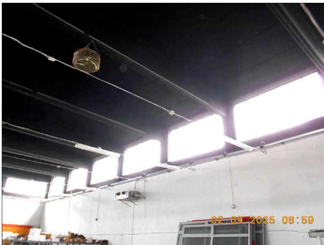
Figura 25 – vista interna dei particolari costruttivi del deposito – magazzino al piano terra
