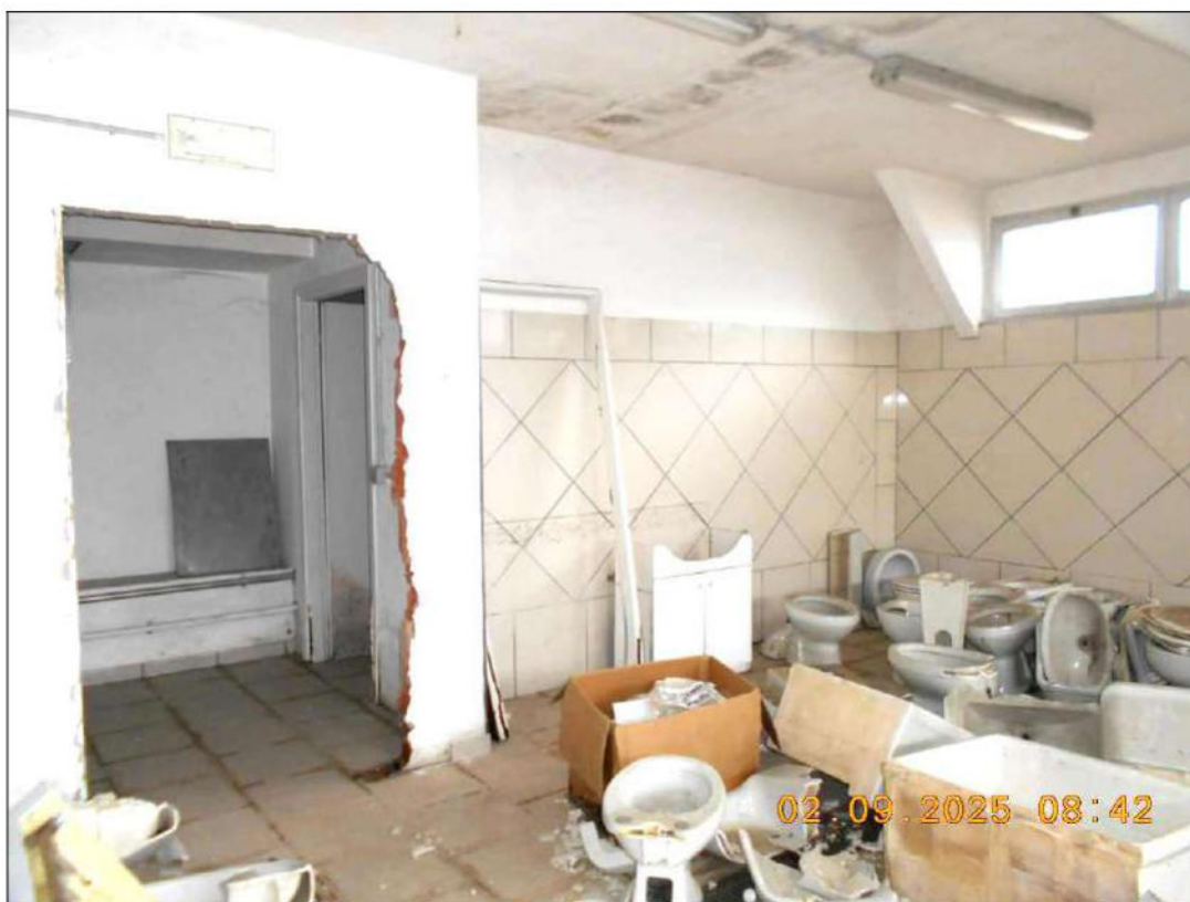
Figura 41 – vista interna dei particolari costruttivi dei locali al piano seminterrato
