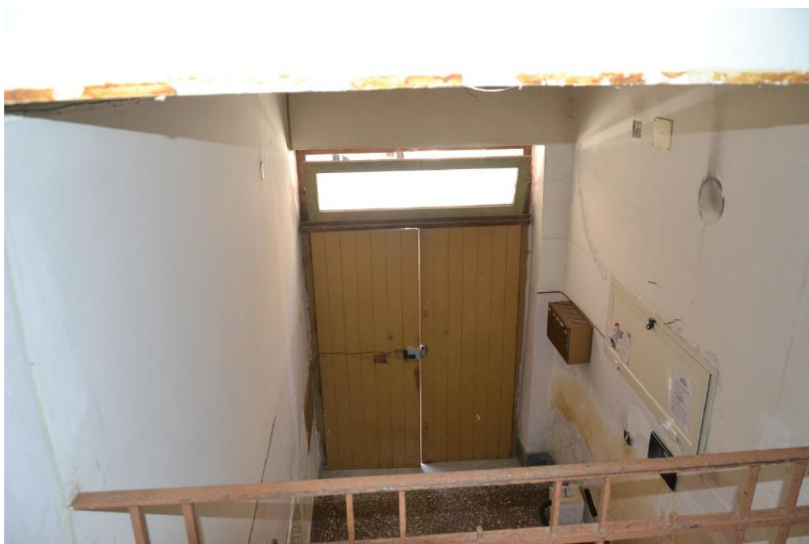
Foto 13: vista ingresso dal vano scala
