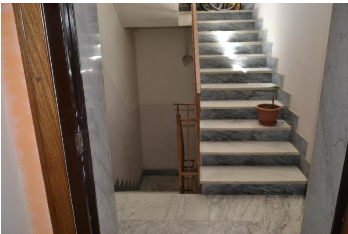
Foto 3: vista vano scala
