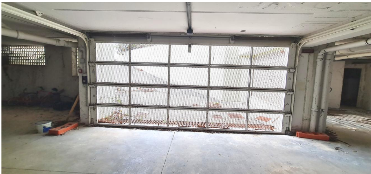
Accesso carrabile con sezionale ad apertura automatizzata, costituito da pannelli forati per l'aerazione, di seguito foto dell'interno dell'intratto
