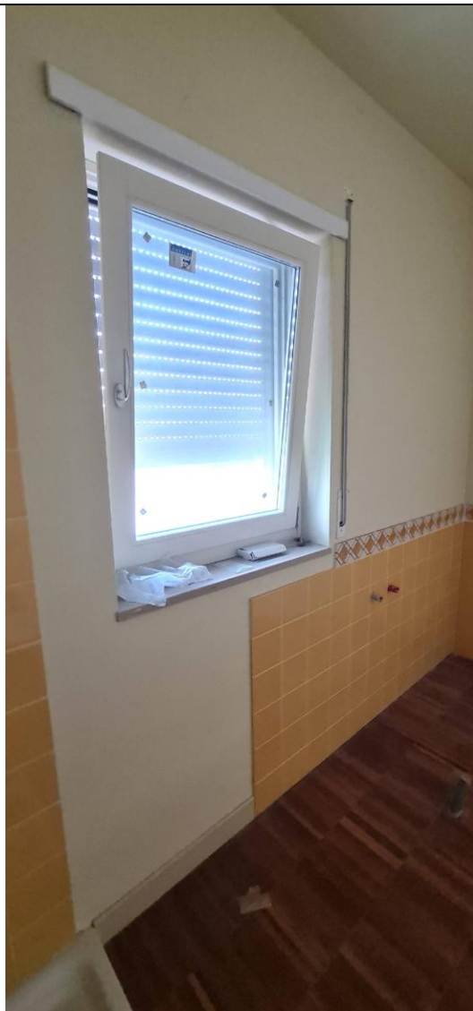
Finestre a doppia apertura tipo vasistas presenti in ogni ambiente, con vetro termo camera
