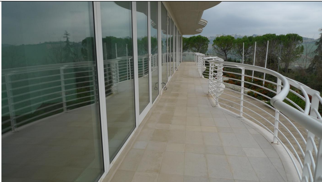
Sopra: Palazzina R5, passerella sbalzo coperta per accesso agli immobili del primo piano
