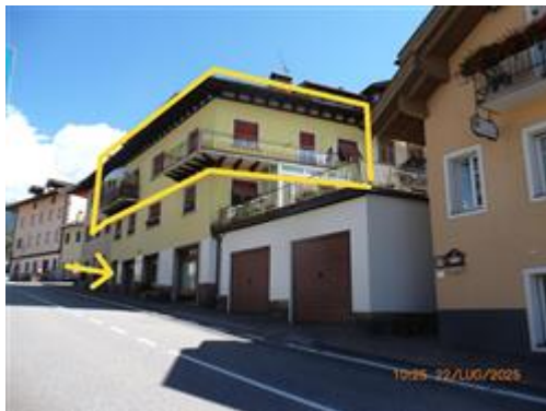
vista ovest: in giallo è indicata l'ubicazione dell'alloggio p.m.2 e con la freccia l'ingresso comune all'edificio
