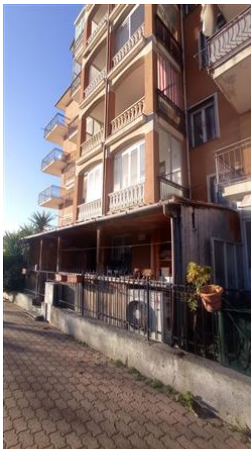
Affaccio su Via Risorgimento, con tettoia non conforme
