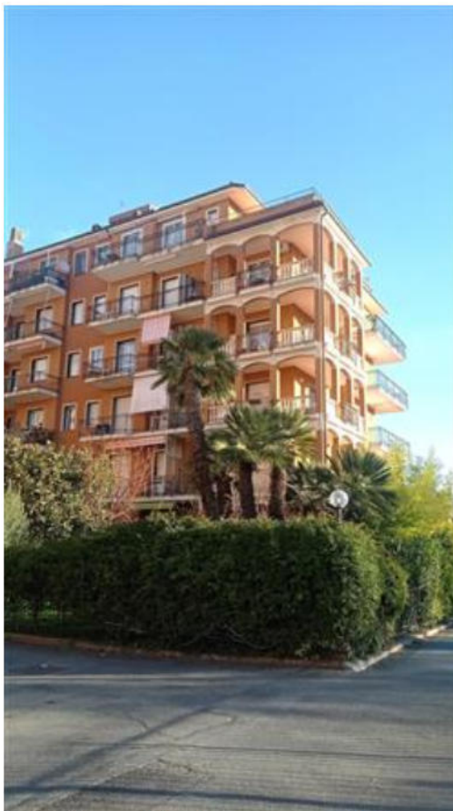
Prospetti sud - ovest del condominio Santa Matilde da Via Cavour
