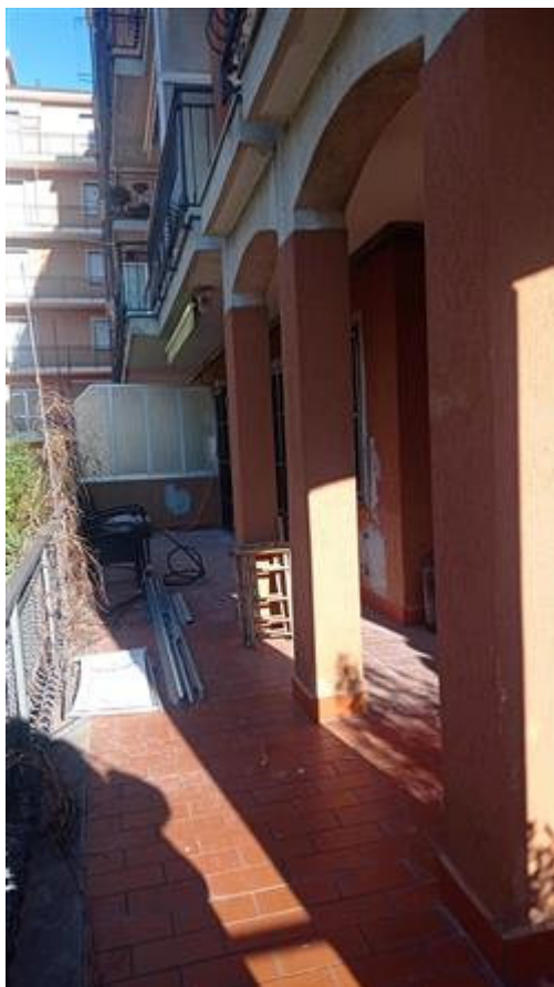
Porticato e balcone esterno
