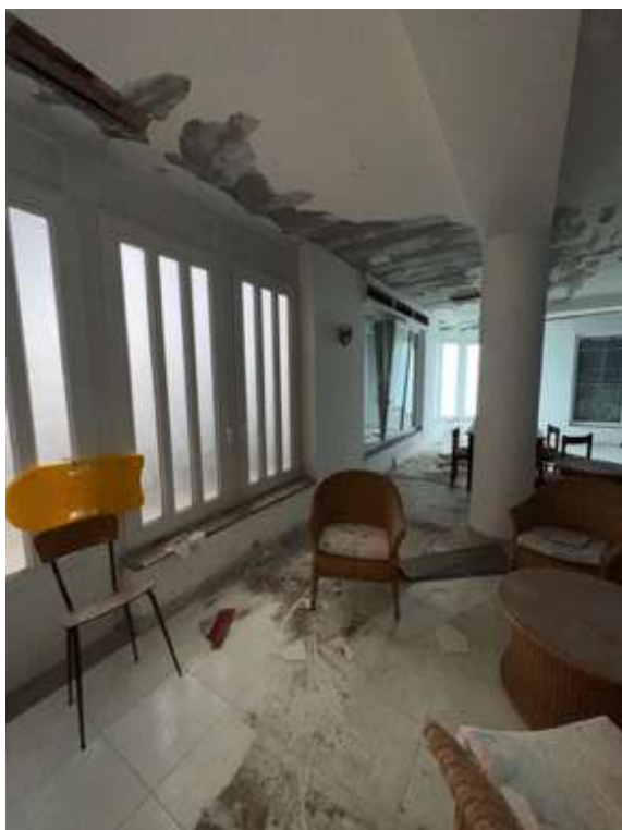
Figura 27 Soggiorno A_solaio ammalorato
