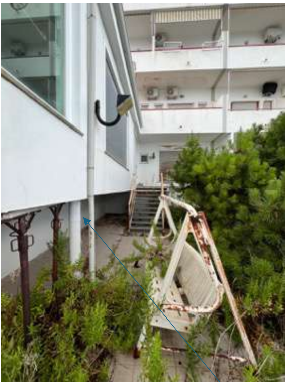
Figura 49 Puntellamento solaio pericolante
