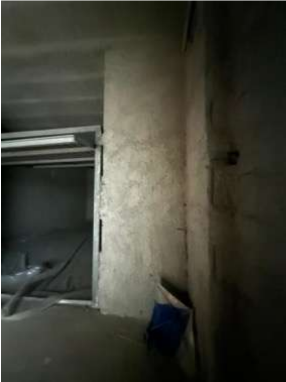
Figura 47 Pareti in stato rustico
