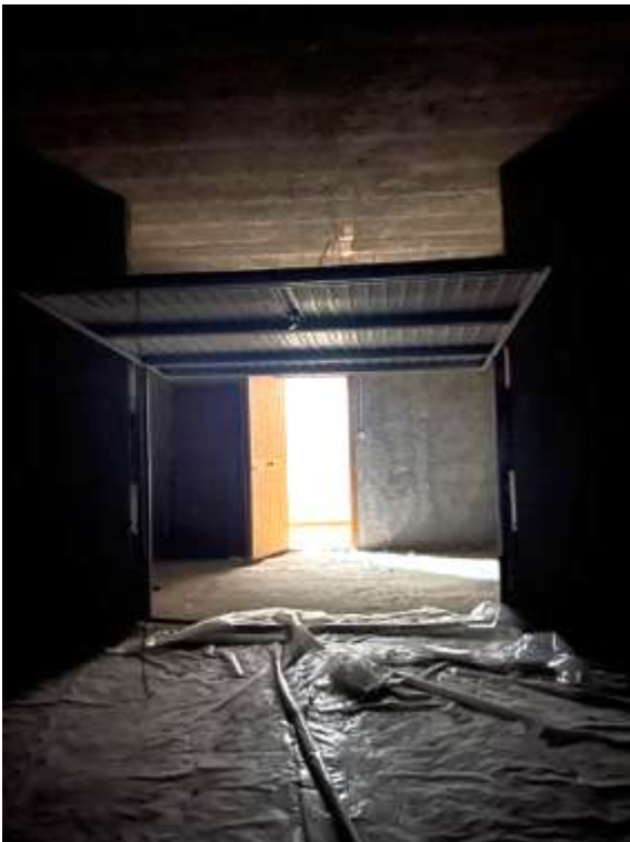
Figura 45 Porta accesso vista dall'interno
