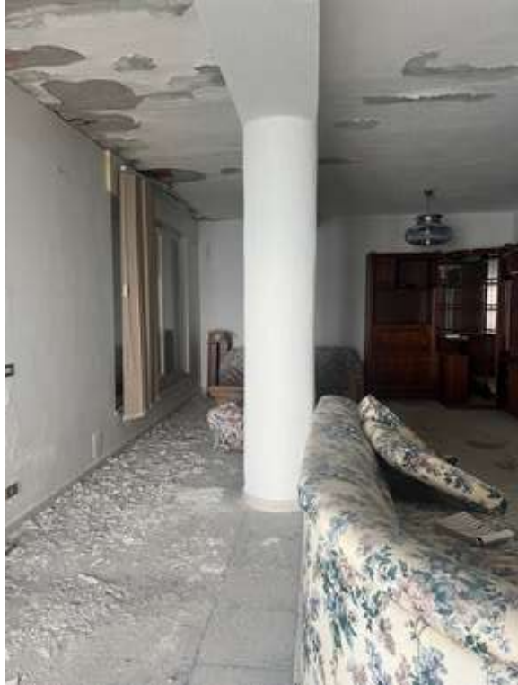
Figura 25 Solaio ammalorato
