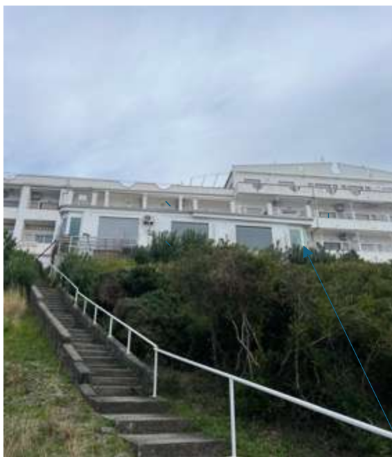
Figura 2 Vista complesso lato mare _ appartamento sub 6-7-8
