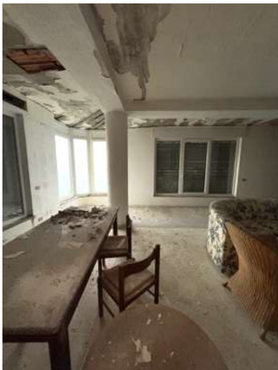
Figura 27 Soggiorno A_solaio ammalorato
