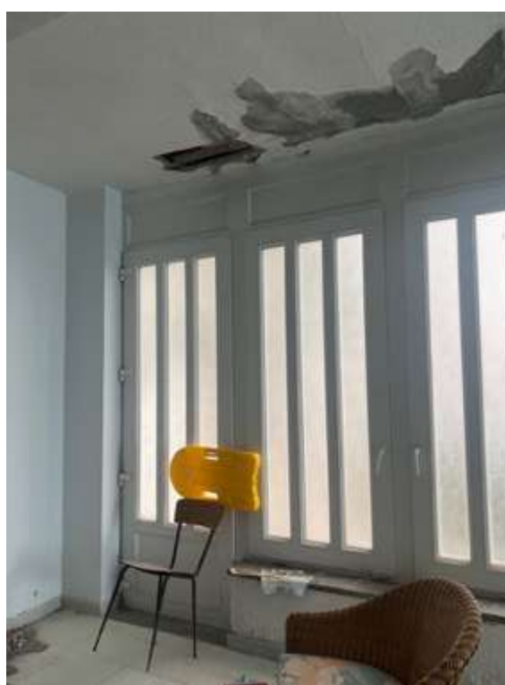
Figura 16 Porta finestra per accesso corte (sub 146)
