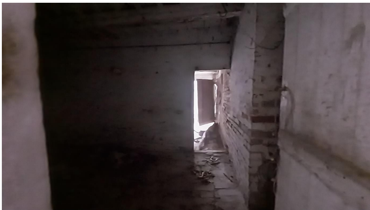
Piano Terra. Vista da Ovest verso Est.
