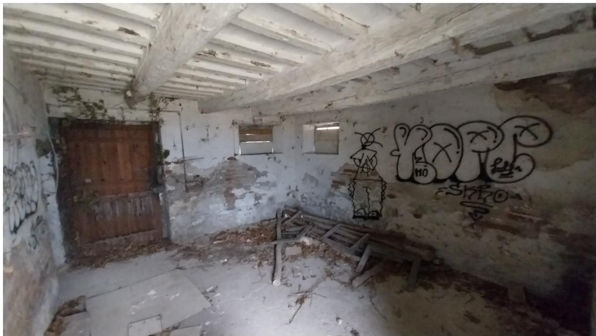
Piano Terra. Stanza lato Ovest.
