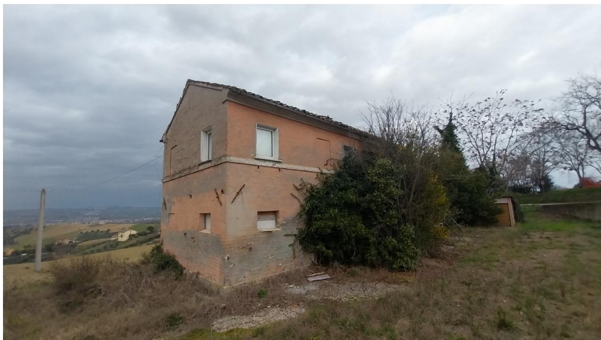
Vista esterna. Spigolo Sud-Ovest.
