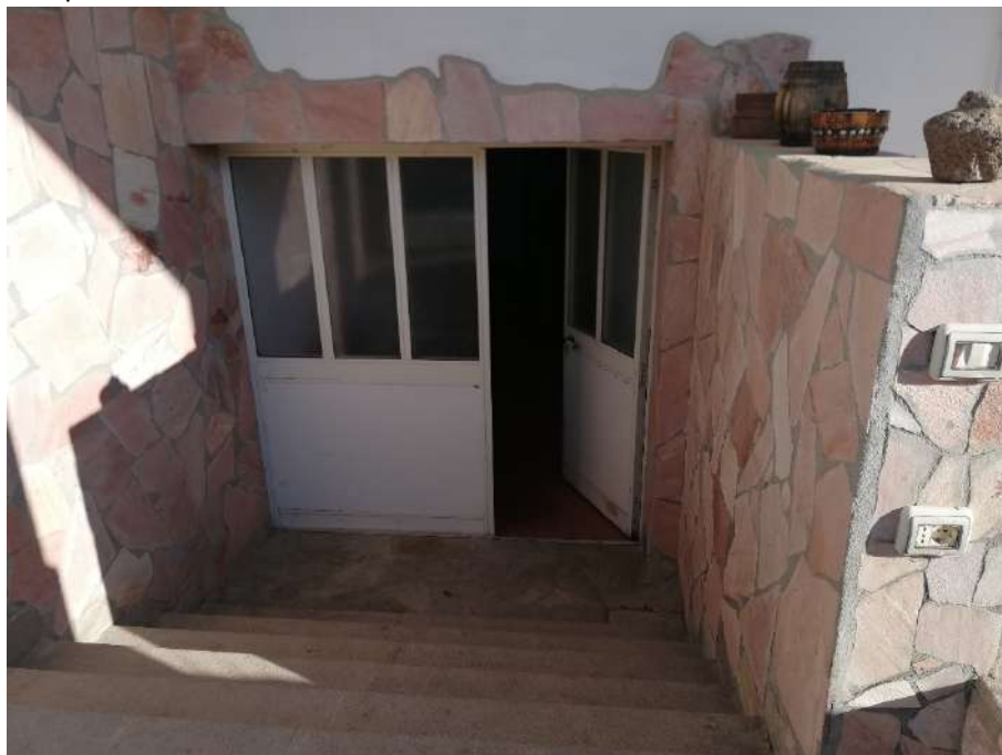
Foto 37) Ingresso al piano seminterrato
