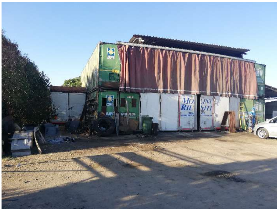
Foto 28) 29) 30) Locali officina da rimuovere, realizzati con l'unione di vecchi container in lamiera e la realizzazione di una tettoia.
