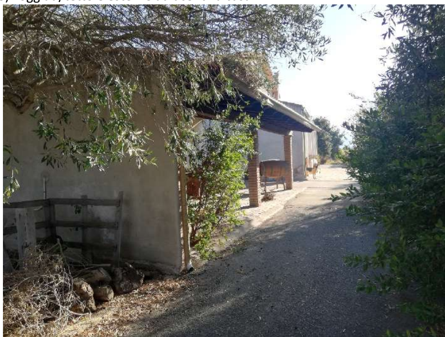
Foto da 58) a 60) Loggiati/tettoie esterne adiacenti la casa
