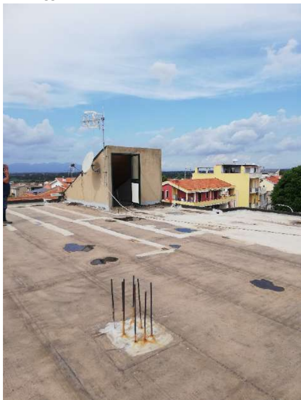
Foto 20) 21) Lastrico solare comune, copertura del maggior fabbricato in Monastir via Monaco.
