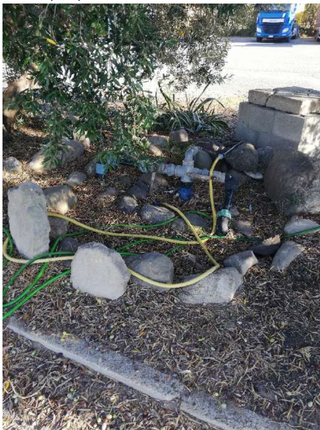
Foto 32) Pozzo artesiano dotato di pompa sommersa.
