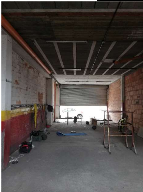
Foto 6) Magazzino al piano terra
