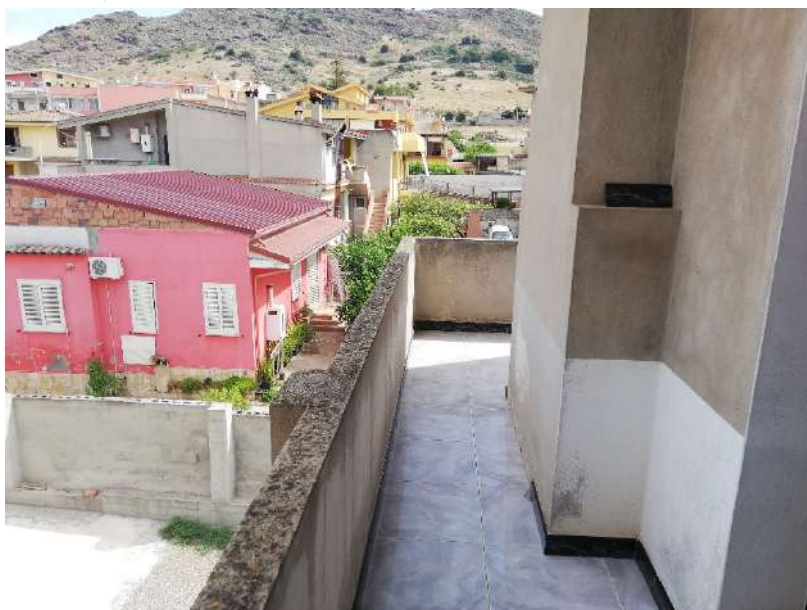
Foto 19) Balcone lato cortile, con accesso dal vano cucina.
