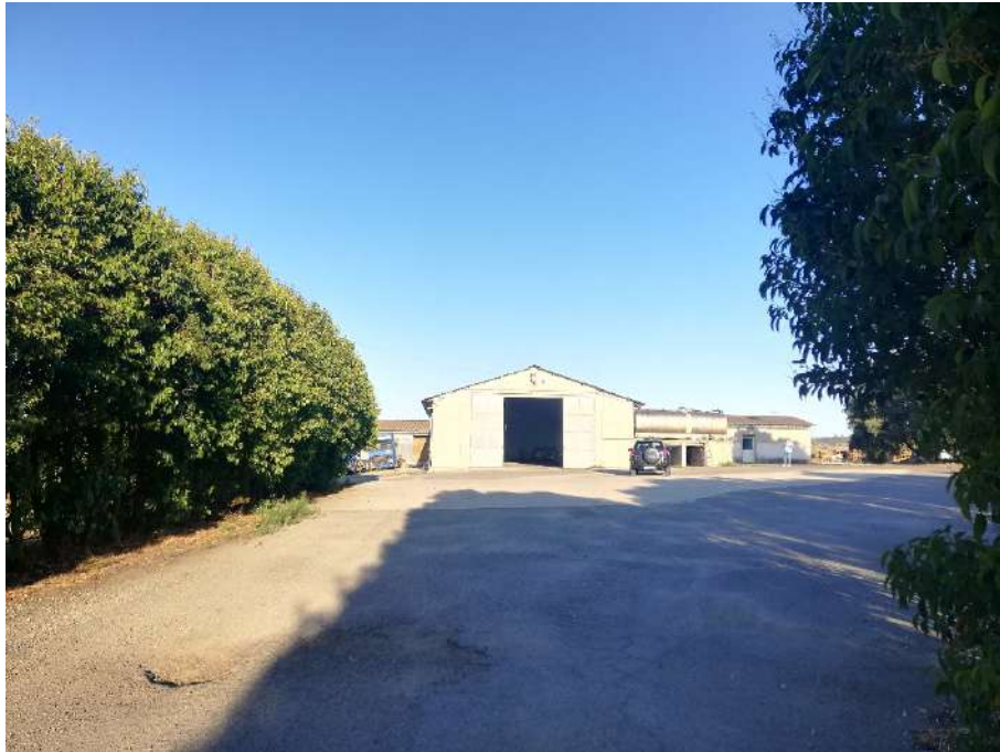
Foto 3) 4) 5) 6) 7) 8) 9) Parti esterne del capannone principale, articolato in più corpi.
