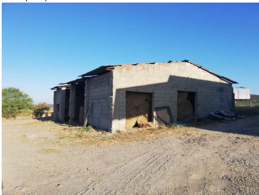
Foto 23) 24) 25) Vecchio e precario locale deposito ricadente sul terreno mappale 38, antistante il capannone principale.
