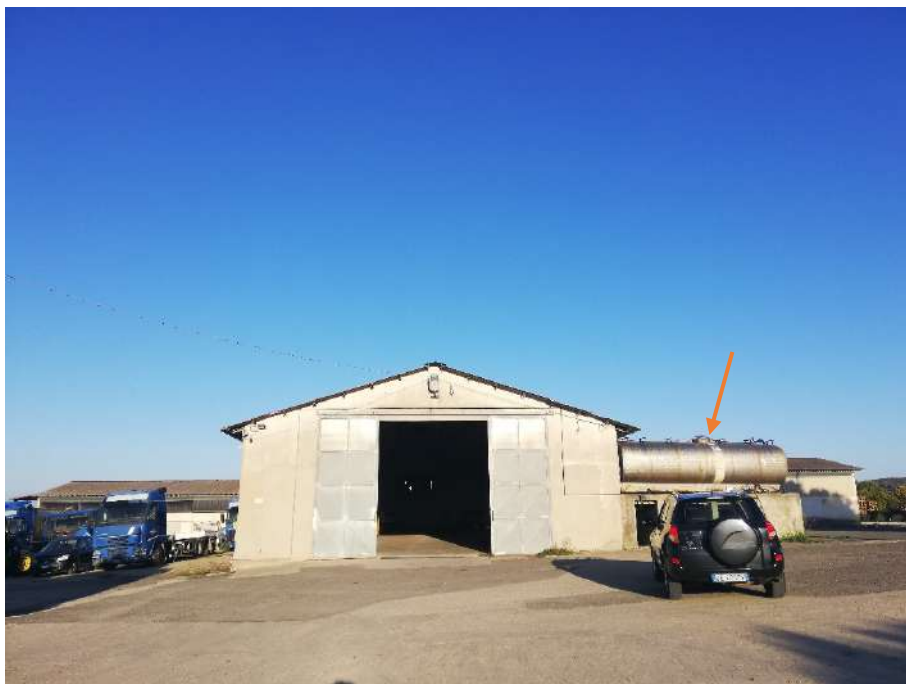
Foto 4) La freccia indica la cisterna con relativa struttura d'appoggio, che si dice destinata a riserva idrica
