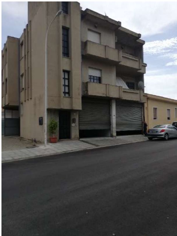
Foto 1) Fronte strada del fabbricato
