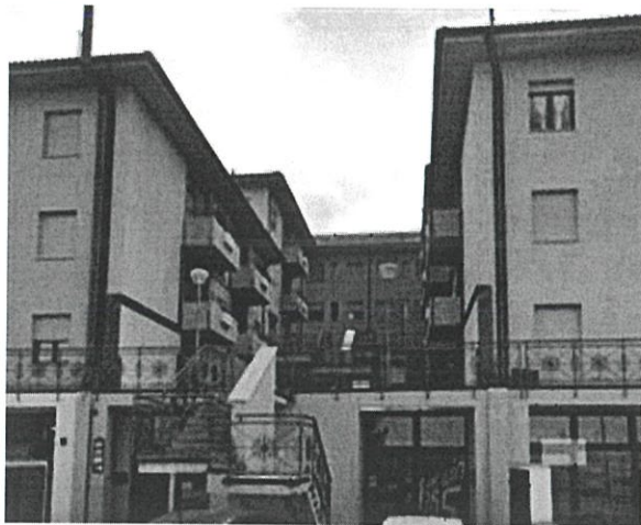
esterno prospetto nord
