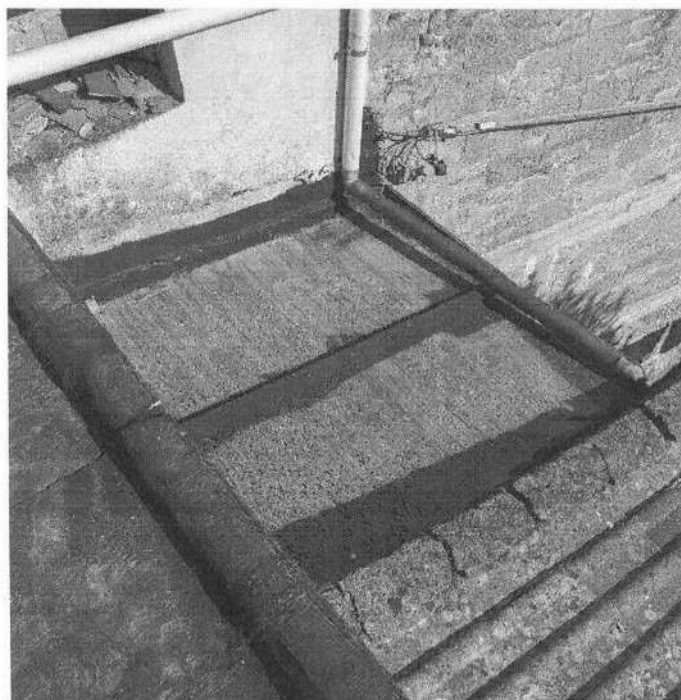
Sopralluogo del 28/06/2023. Botola, eventualmente da ripristinare, al fine di rendere più agevole l'accesso al tetto.
