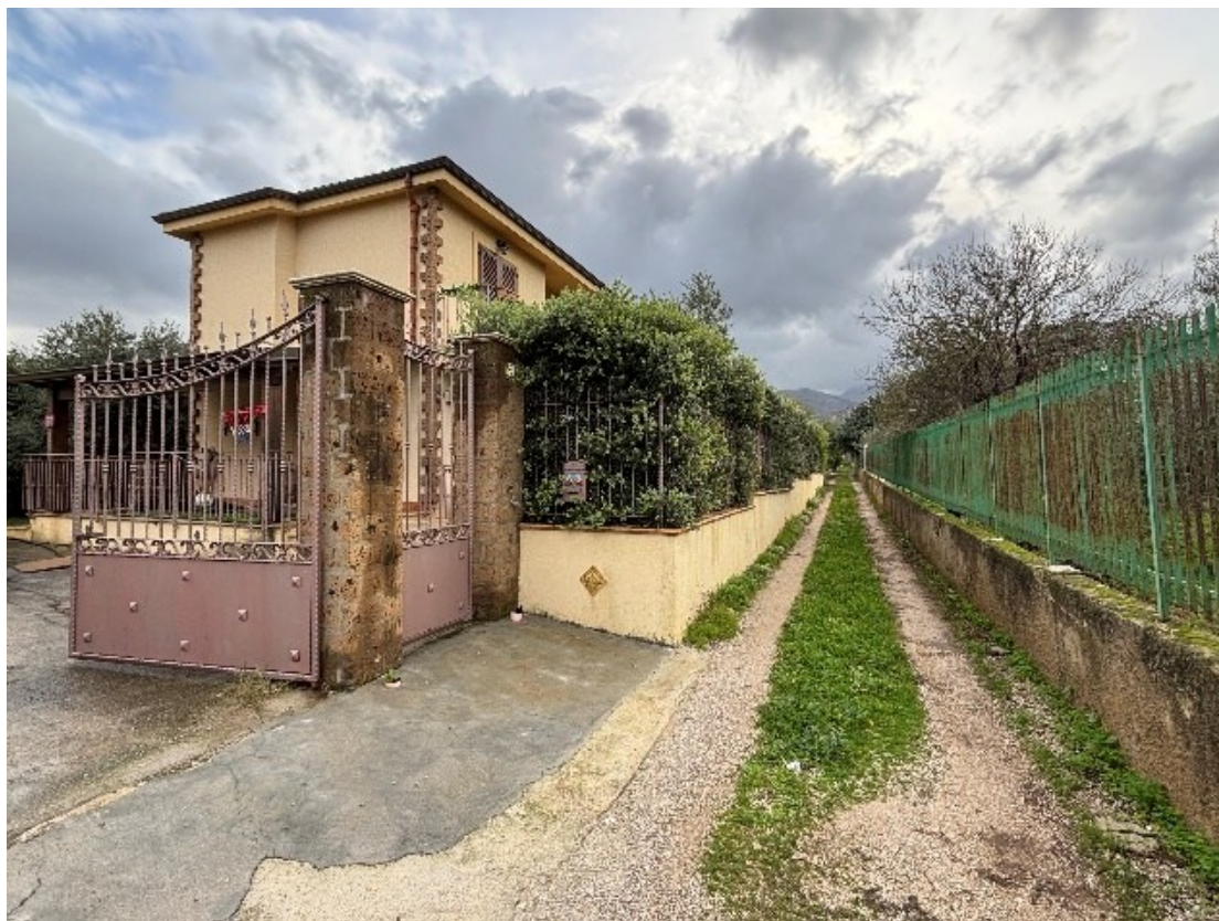
Foto n. 1 – Accesso da via del Cormorano
