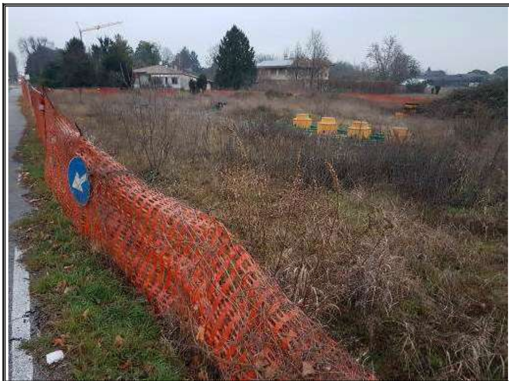
Foto n. 23 Impianto in corso di costruzione in Comune di Cervignano del Friuli
