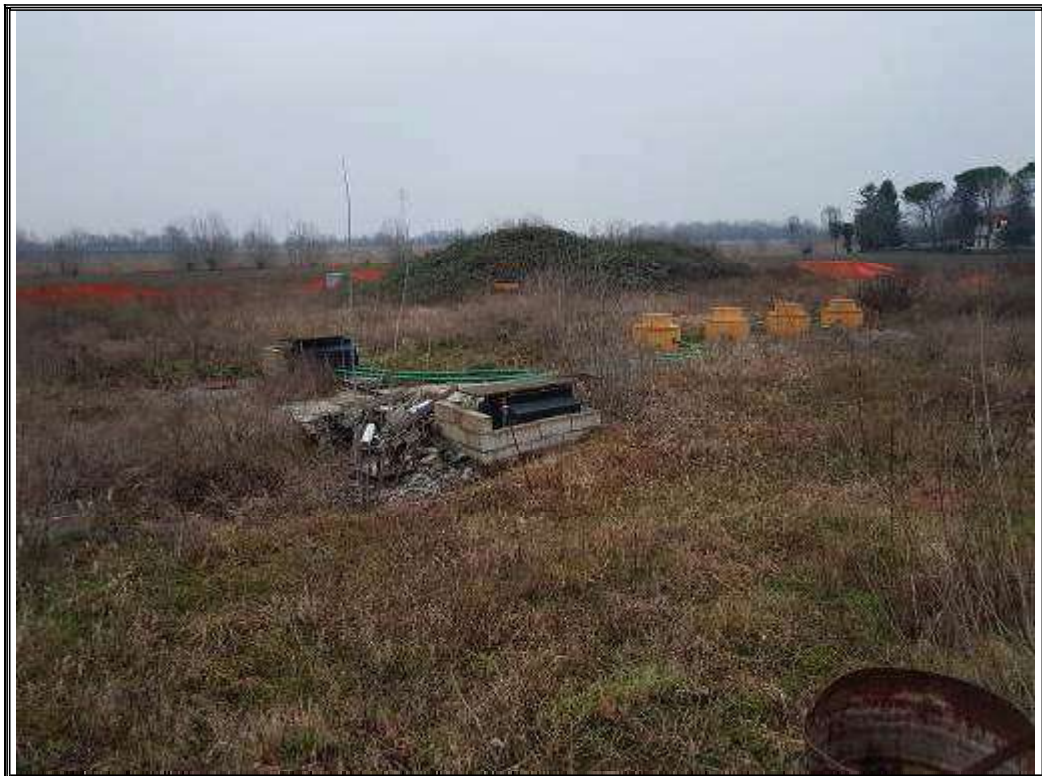
Foto n. 26 Impianto in corso di costruzione in Comune di Cervignano del Friuli
