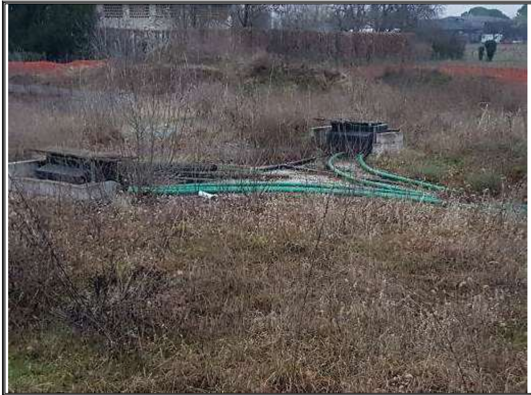
Foto n. 25 Impianto in corso di costruzione in Comune di Cervignano del Friuli
