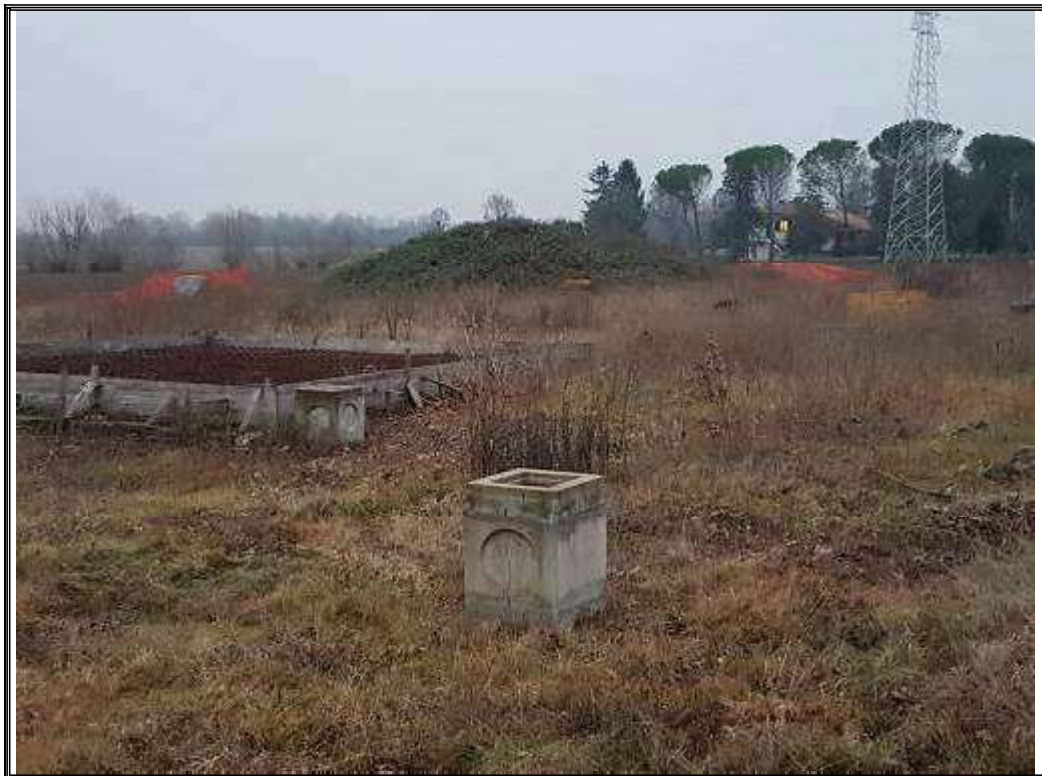
Foto n. 28 Impianto in corso di costruzione in Comune di Cervignano del Friuli
