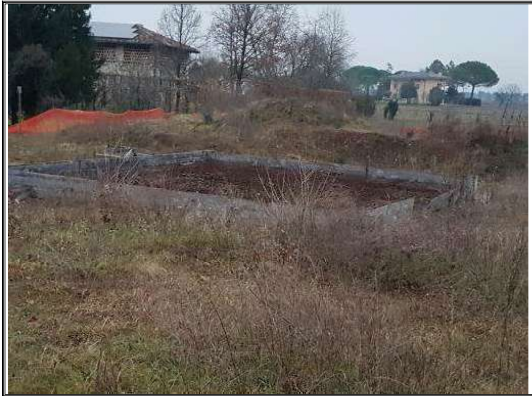
Foto n. 27 Impianto in corso di costruzione in Comune di Cervignano del Friuli
