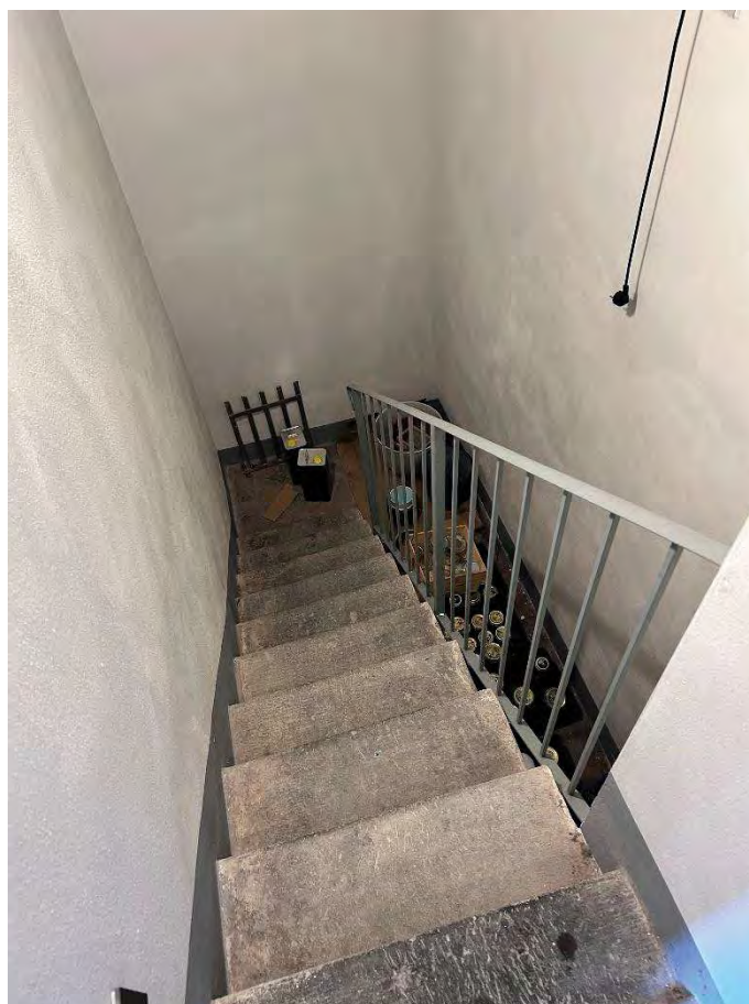
FOTO 23) RIPOSTIGLIO CON ACCESSO DALLA CUCINA
