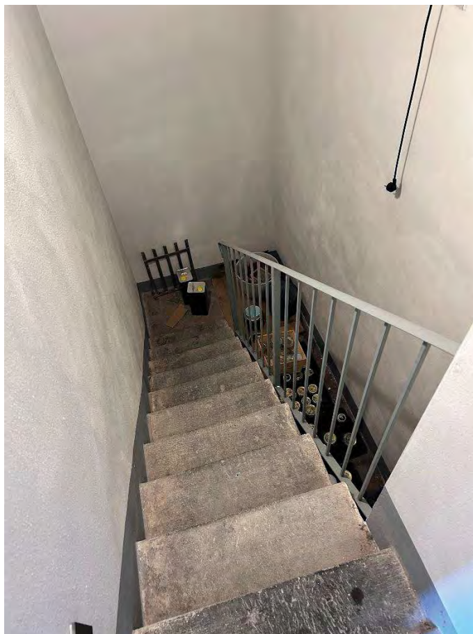
FOTO 23) RIPOSTIGLIO CON ACCESSO DALLA CUCINA
