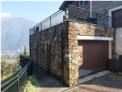
esterno autorimessa sub. 702
