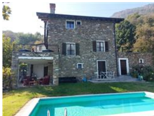
vista est fabbricato sub. 701 e autorimessa sub. 702
