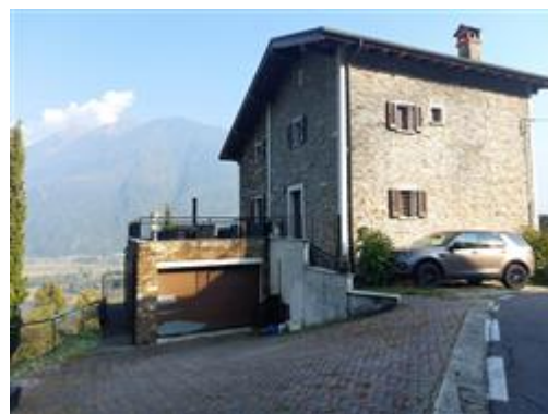
vista nord-ovest fabbricato sub. 701 e autorimessa sub. 702
