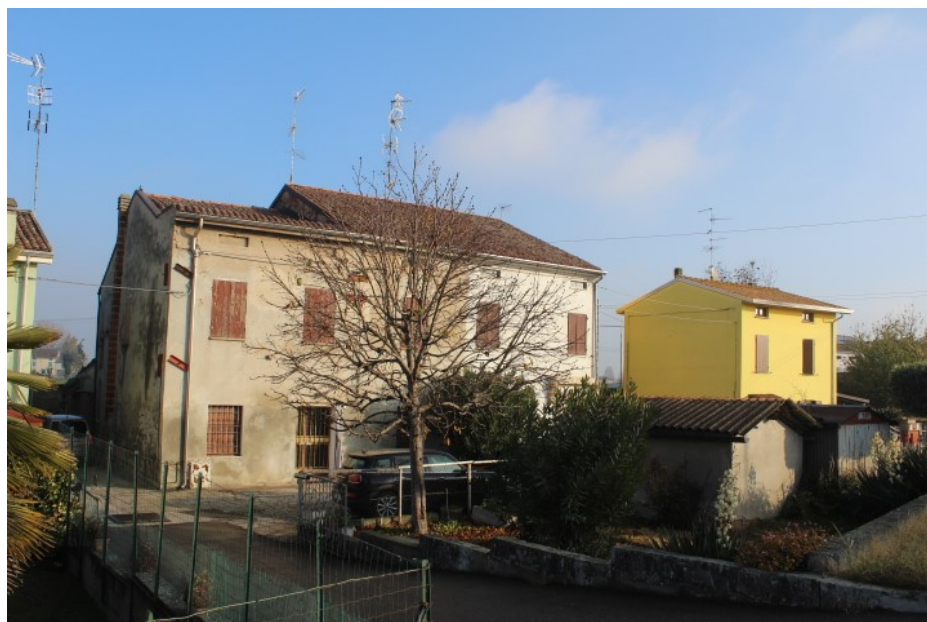
LOTTO UNICO – QUOTA PORZIONE FABBRICATO ABITATIVO GUASTALLA
