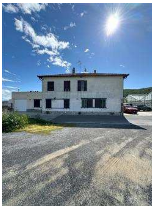
Vista del prospetto Ovest dell'immobile da via Ilaria Alpi
