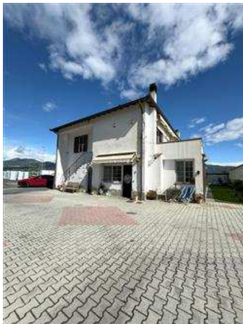
Vista del prospetto Sud dell'immobile dal piazzale privato
