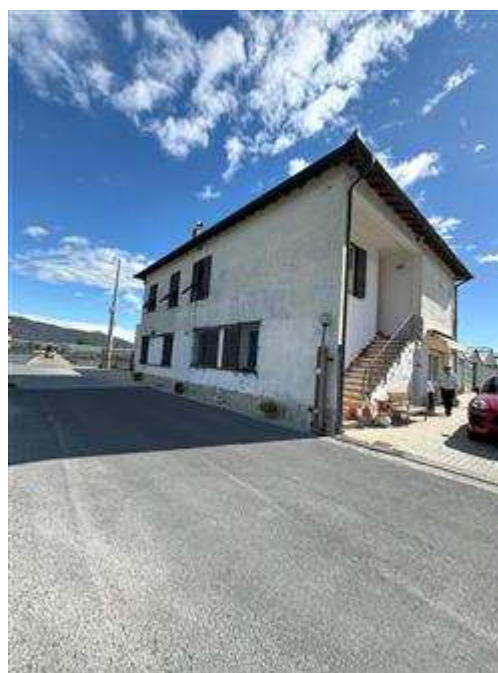
Vista del prospetto Sud-Ovest dell'immobile da via Ilaria Alpi
