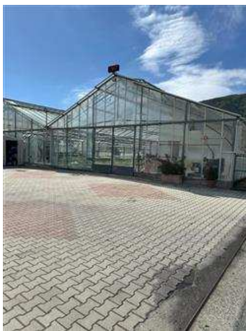
Vista piazzale davanti all'immobile
