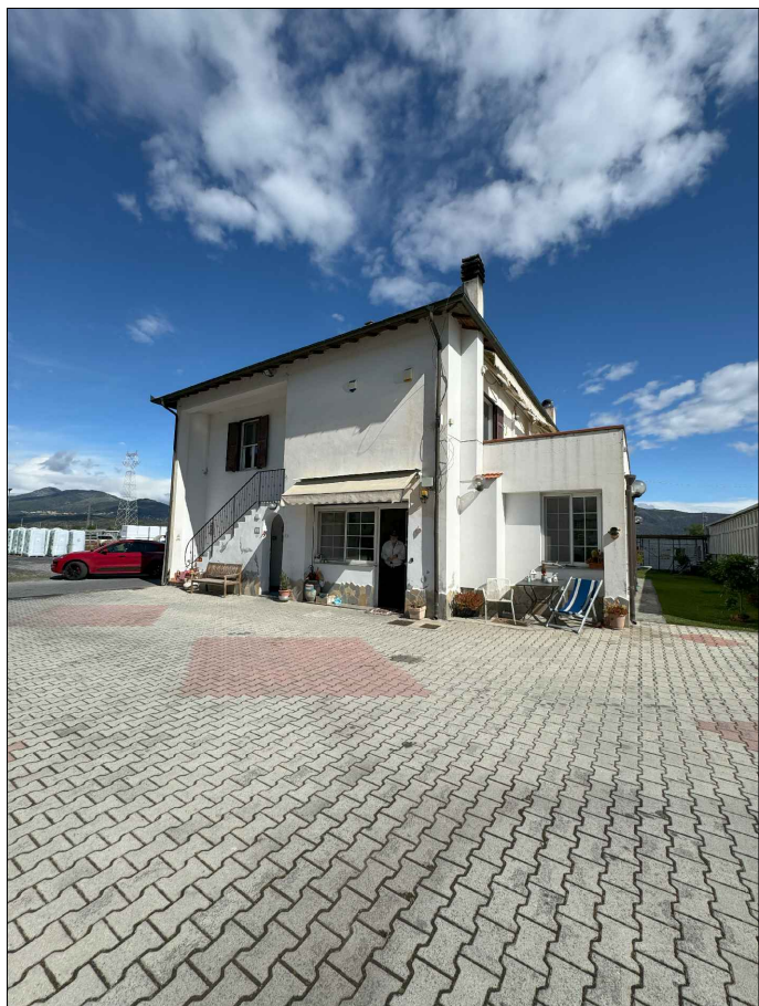
01_ Prospetto esterno su piazzale interno
