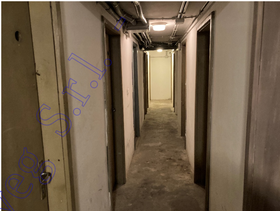
Vista interni scantinato
