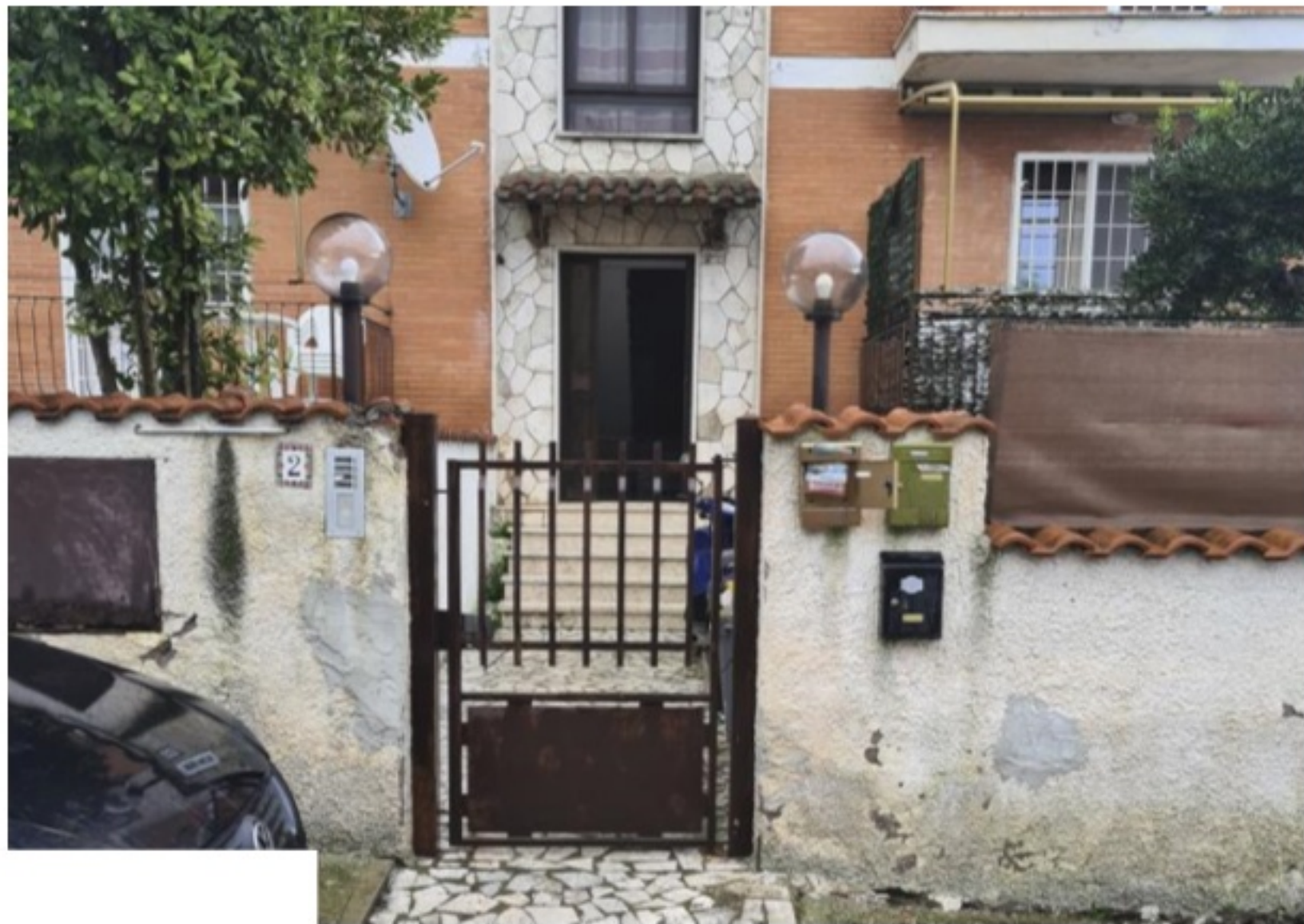
Foto n°4 - Cancellotto pedonale di ingresso al civico 2 di via dei Tulipani
