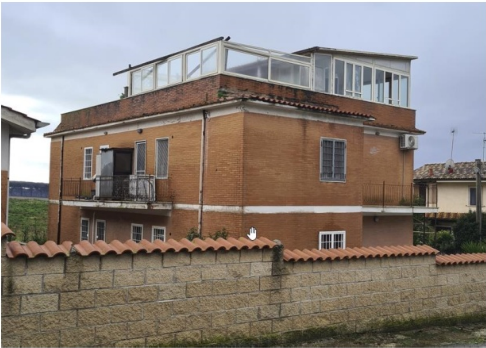
Foto n°3 - Vista del fabbricato da via dei Mughetti
