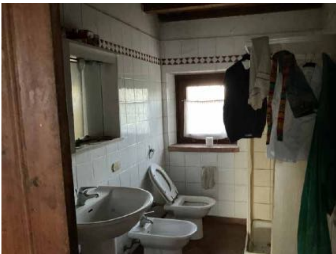
foto 44 - vista abitazione (mapp.le 278)
