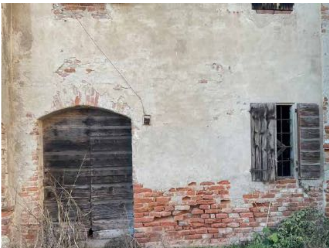
foto 10 - vista abitazione (mapp.le 279)
