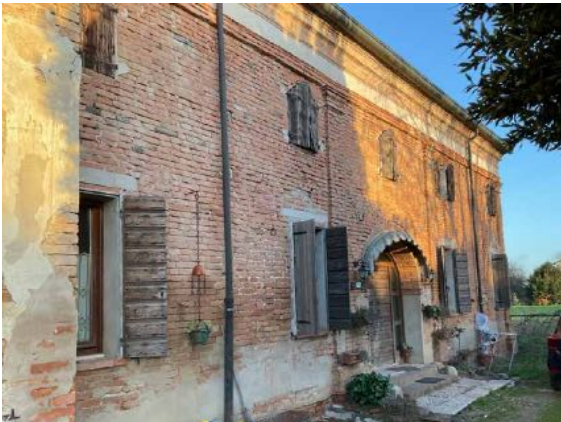
foto 31 - vista abitazione (mapp.le 278)
