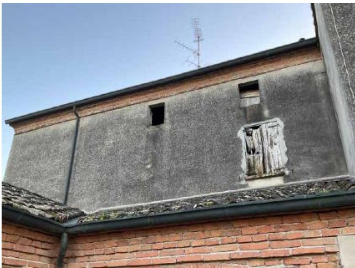
foto 33 - vista abitazione (mapp.le 278)
