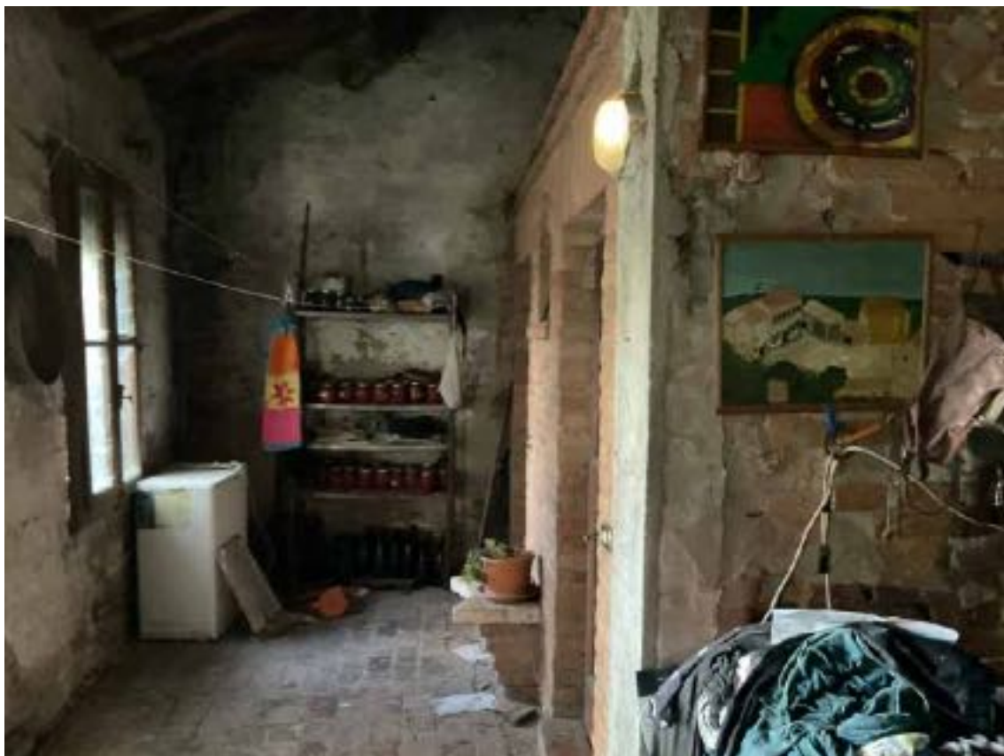
foto 43 - vista abitazione (mapp.le 278)
