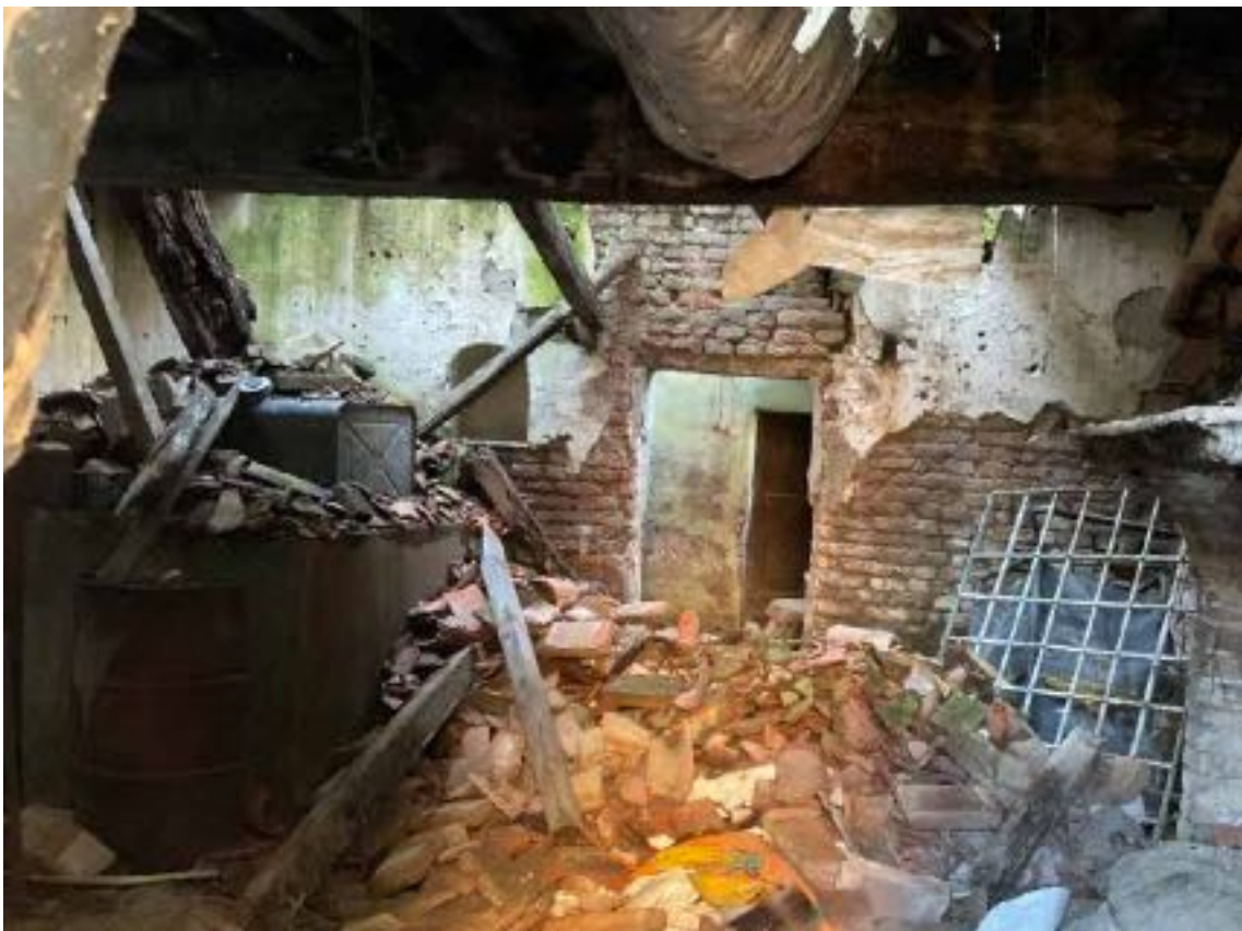
foto 12 - vista abitazione (mapp.le 279)
