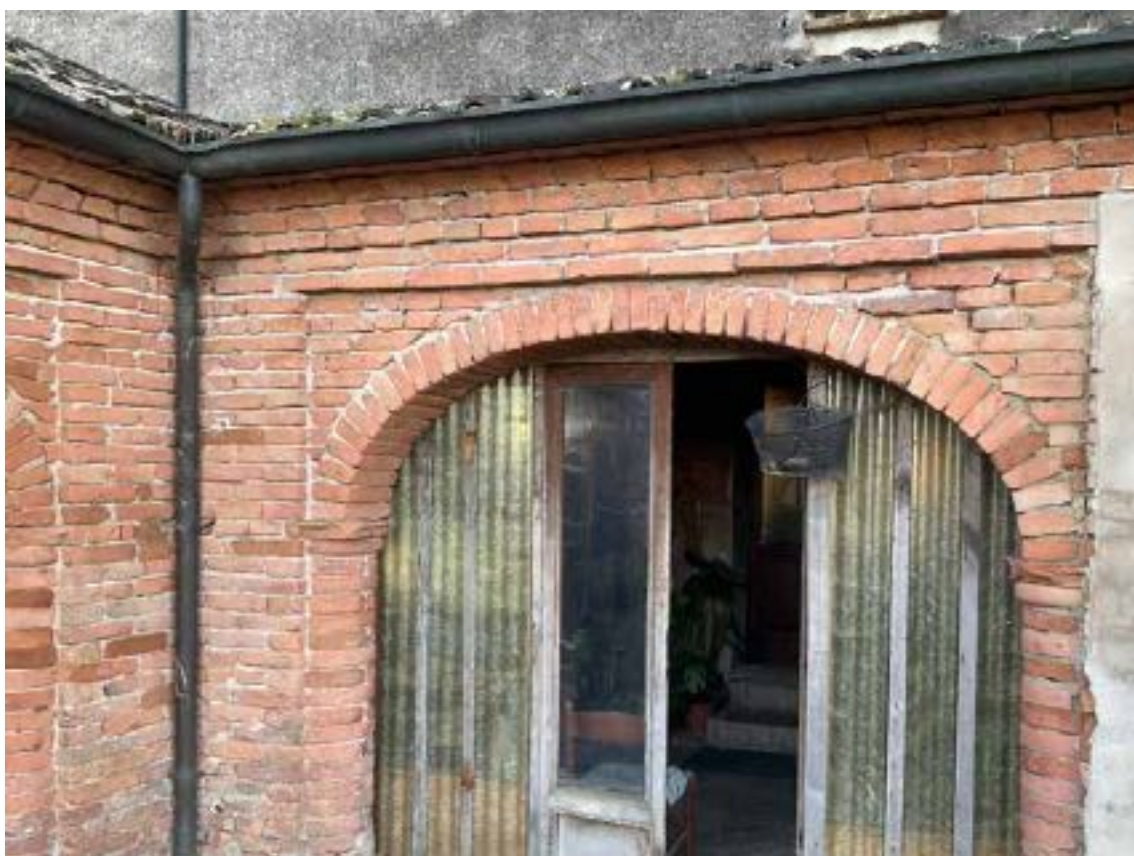
foto 34 - vista abitazione (mapp.le 278)
