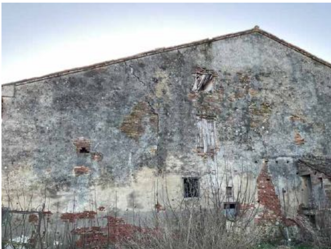
foto 09 - vista abitazione (mapp.le 279)
