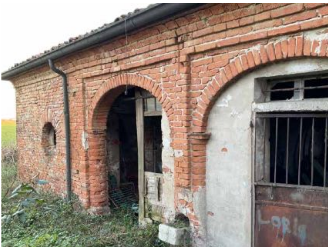
foto 32 - vista abitazione (mapp.le 278)
