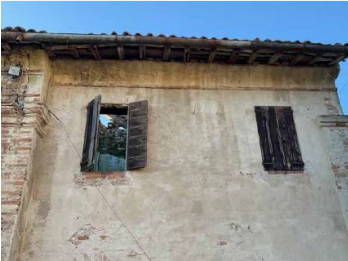
foto 11 - vista abitazione (mapp.le 279)
