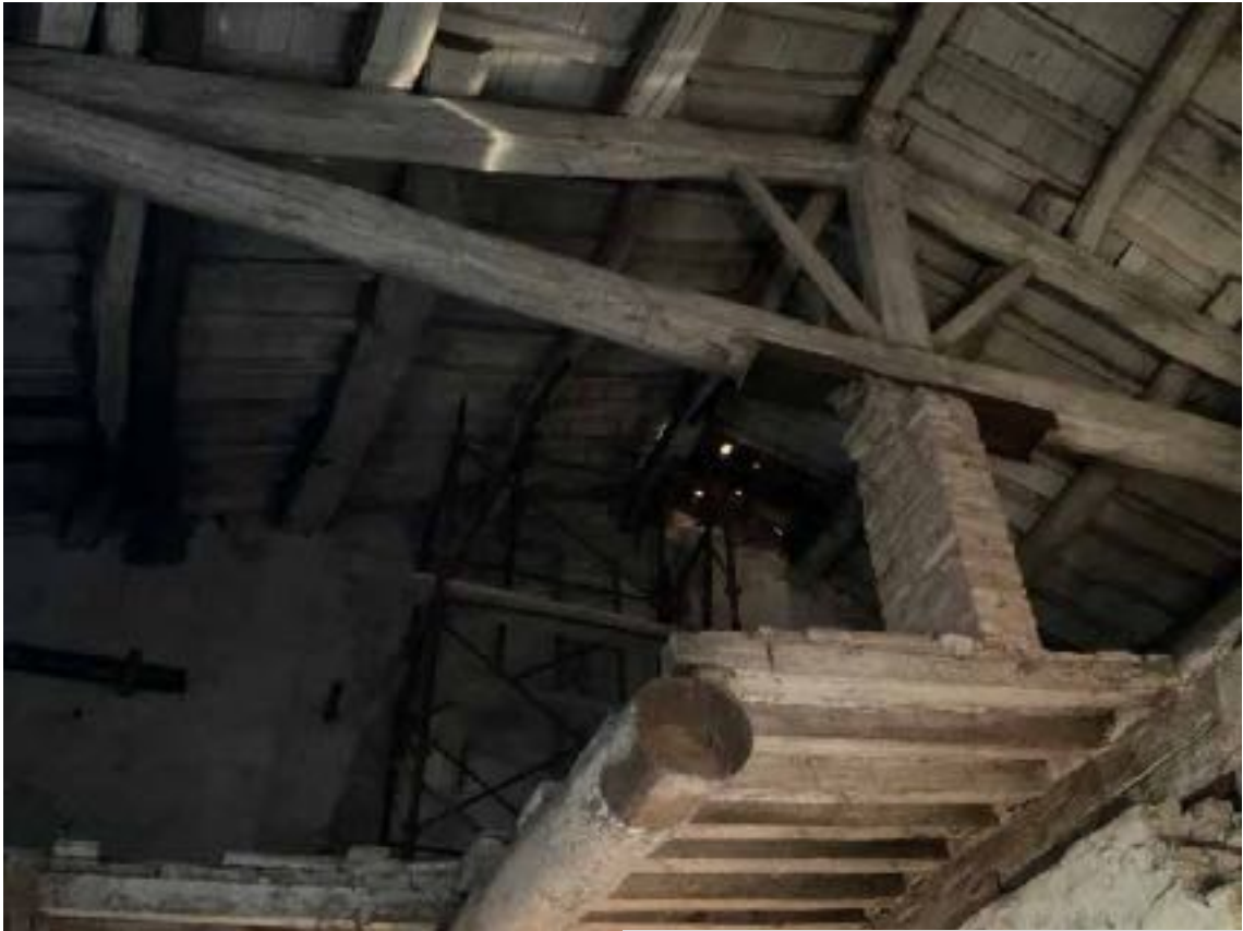
foto 15 - vista locali di deposito (mapp.le 278)
