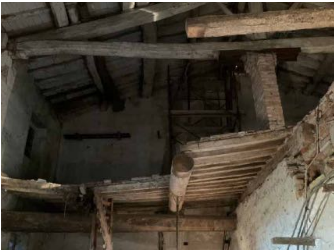
foto 16 - vista locali di deposito (mapp.le 278)
