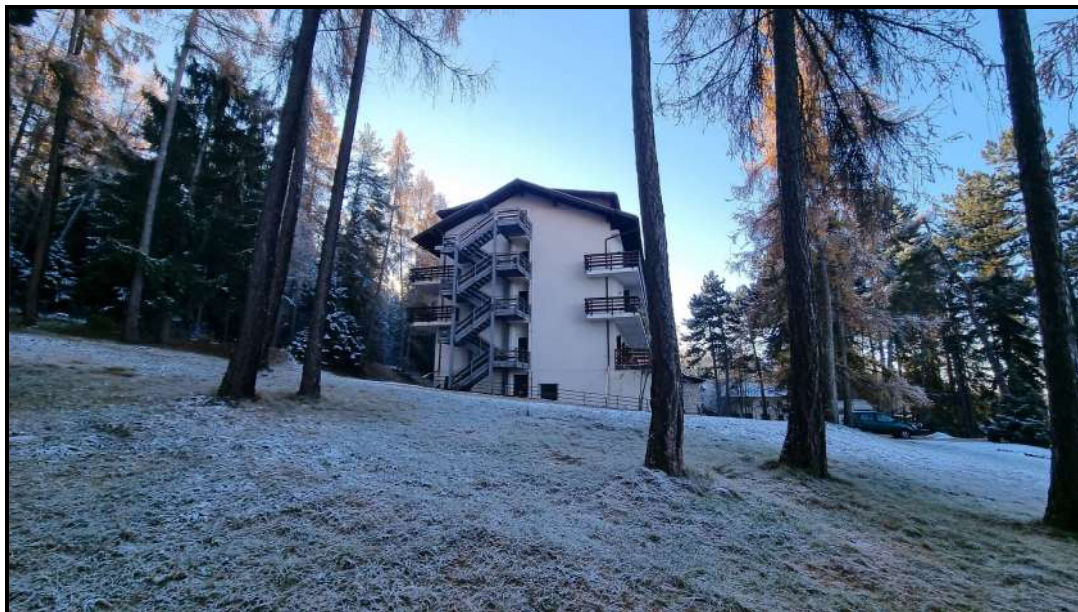
VISTA ANDITO (parziale) NORD
