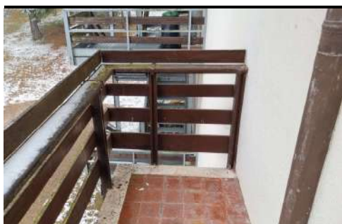
PIANO TERZO – POGGIOLO ANTINCENDIO
