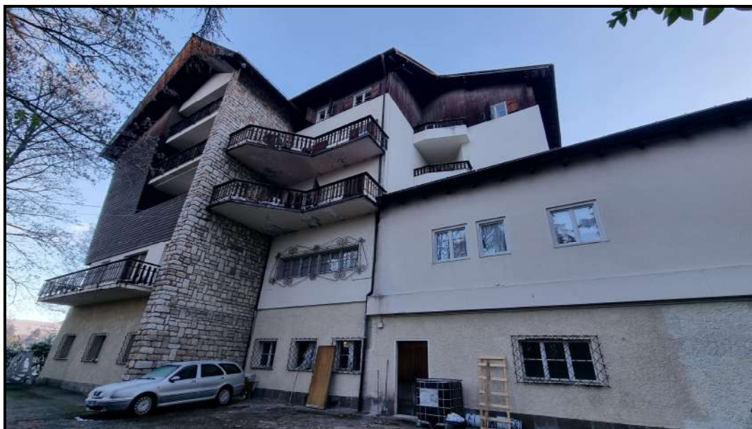
VISTA PROSPETTO (parziale) OVEST
