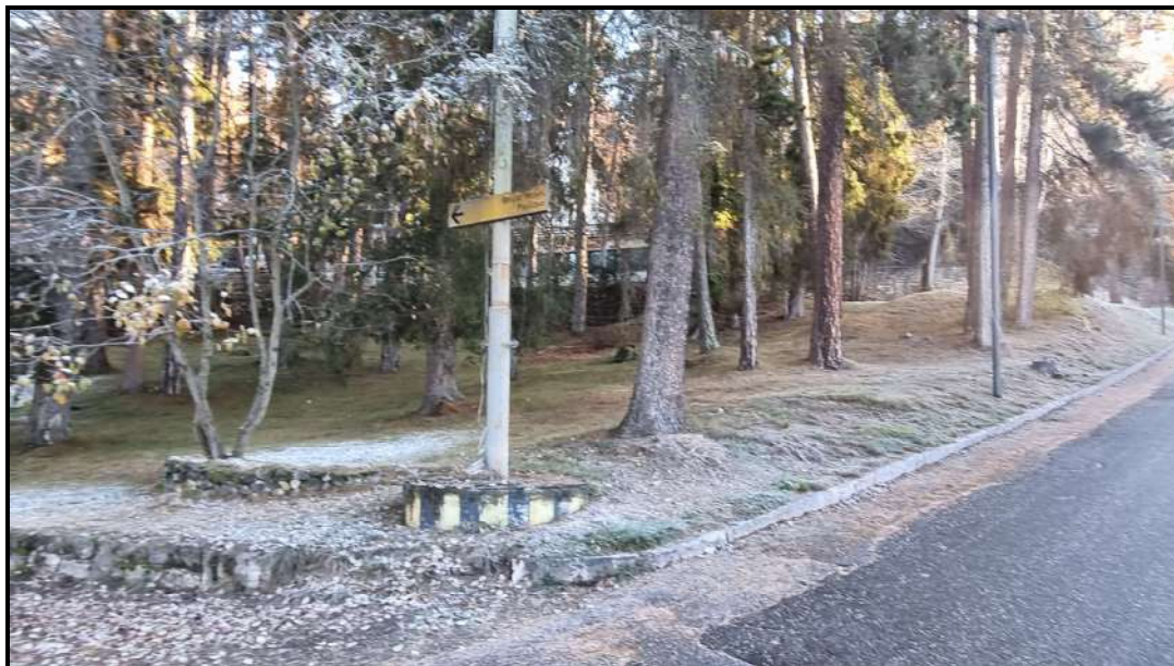
VISTA ANDITO P.F. 1077/15 (parziale) E STRADA COMUNALE SUD- OVEST
