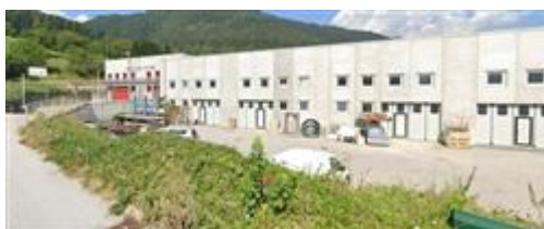
vista da sud - porzione capannone oggetto di esecuzione ultimo a sinistra
