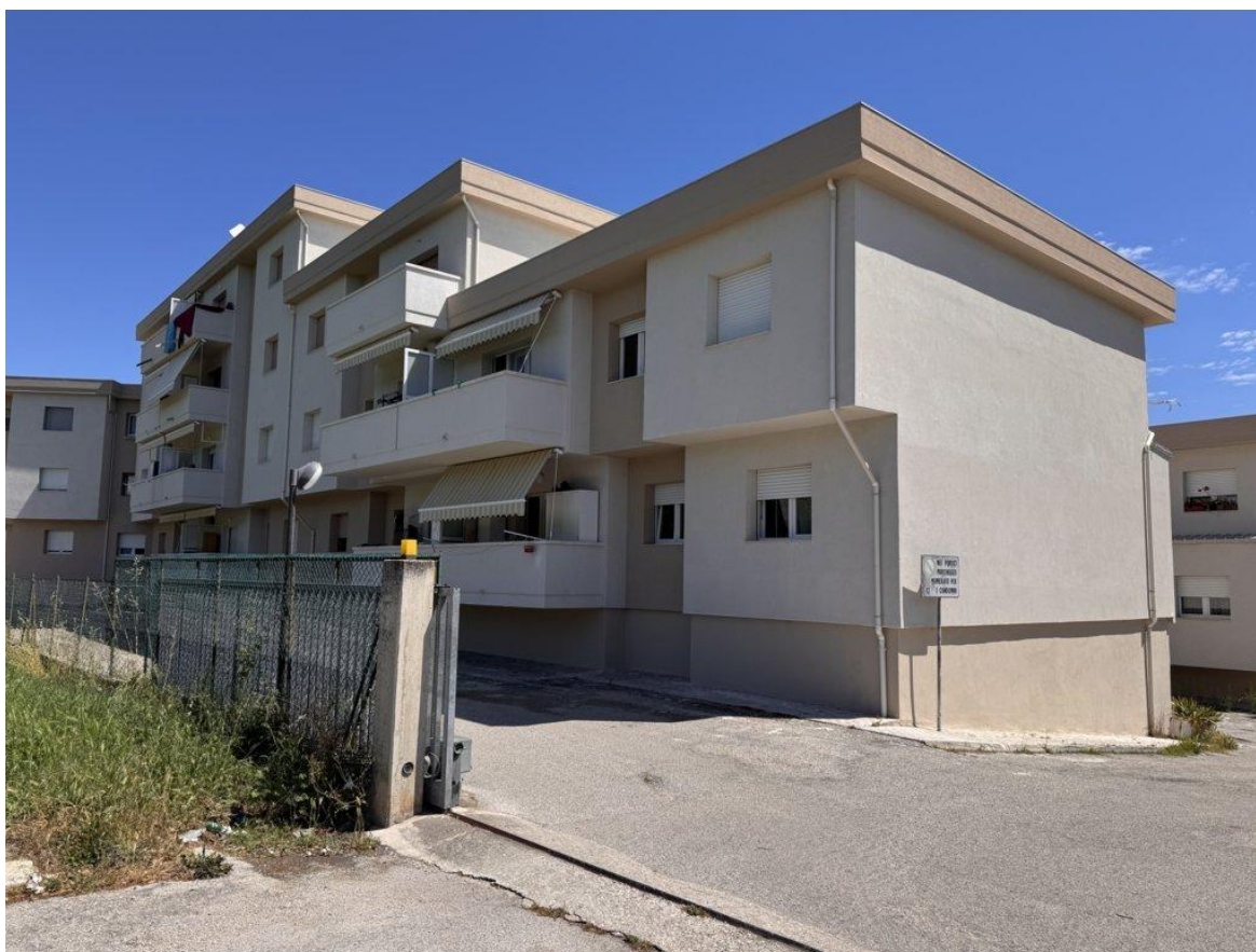
2. Vista angolo sud-ovest del fabbricato
