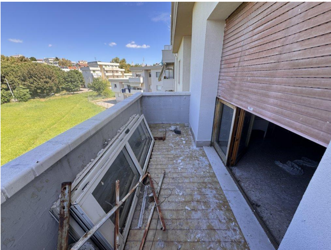
11. Vista del balcone sul lato ovest
