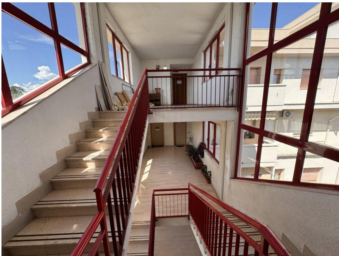
7. Vista della scala condominiale d'accesso all'immobile
