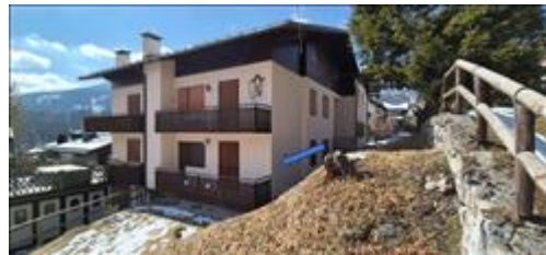
Prospetto Sud/Est (in evidenza appartamento P.M.2)
