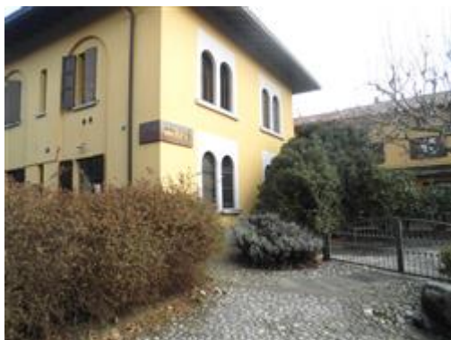
Cascina Grillo adiacente
