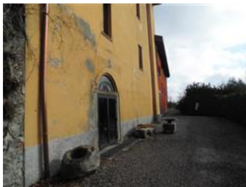
Cascina Grillo adiacente
