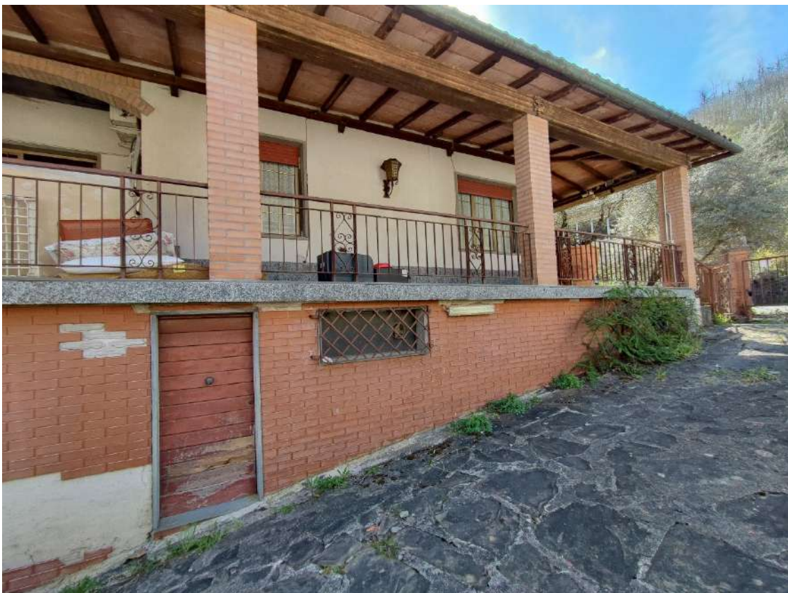
FOTO 18: Portico lato ovest ed accesso a cantina
