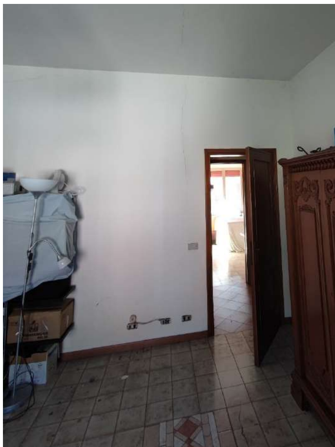
FOTO 15: Camera a nord-ovest (si nota la lesione su pavimento, parete e soffitto)
