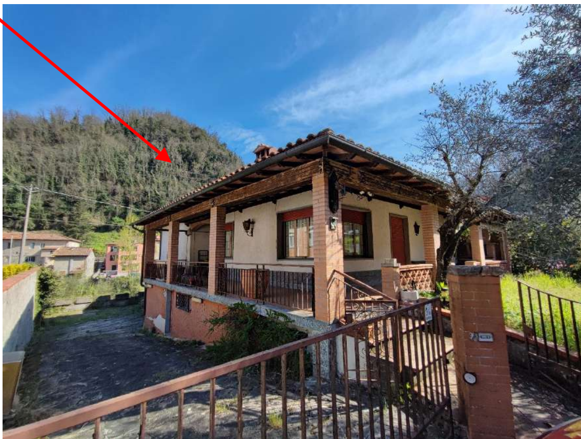
FOTO 1: Vista da nord - individuazione corpo A
