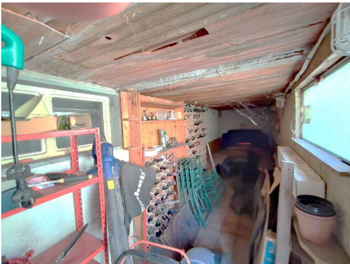
FOTO 19: Cantina a piano seminterrato
