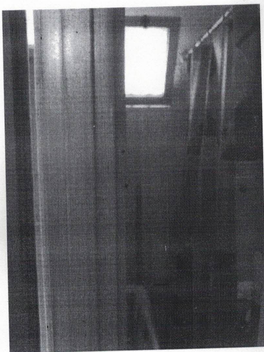
Foto 40- BAGNO VISTA EST - OVEST
