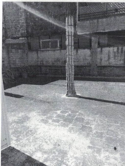
Foto 28- LASTRICO SOLARE VISTA SUD - NORD
