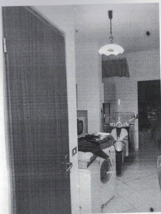
Foto 38- PARTICOLARE MURO DIVISORIO
