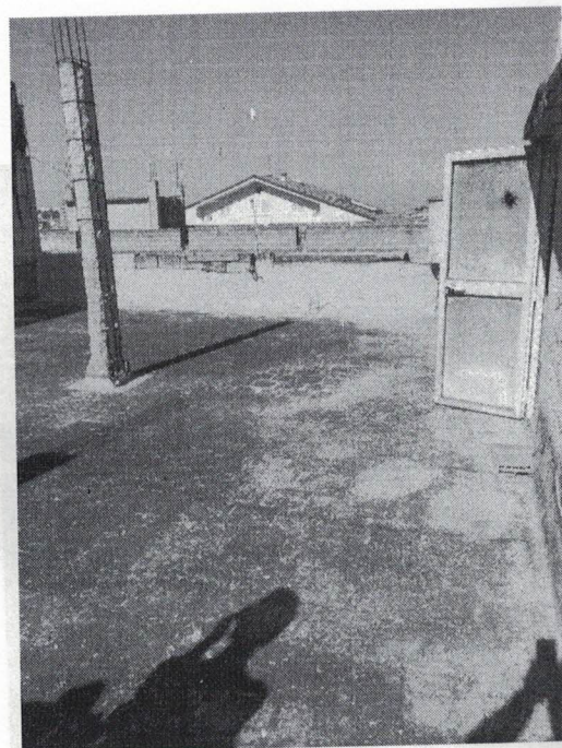
Foto 32- LASTRICO SOL. ALTRA VISTA EST - OVEST
