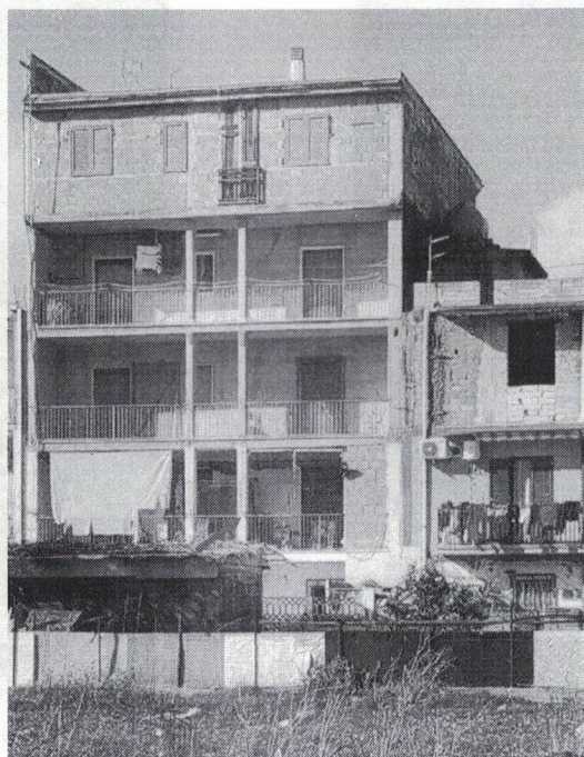
Foto 445- PROSPETTO EST SULLA CORTE PRIVATA – PIANO PRIMO
