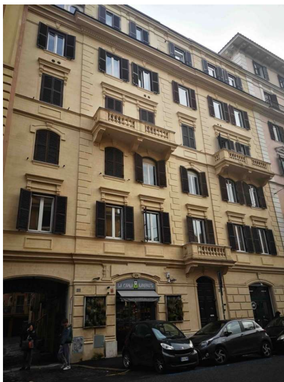
Prospetto del fabbricato su via di Porta Castello – foto 3
