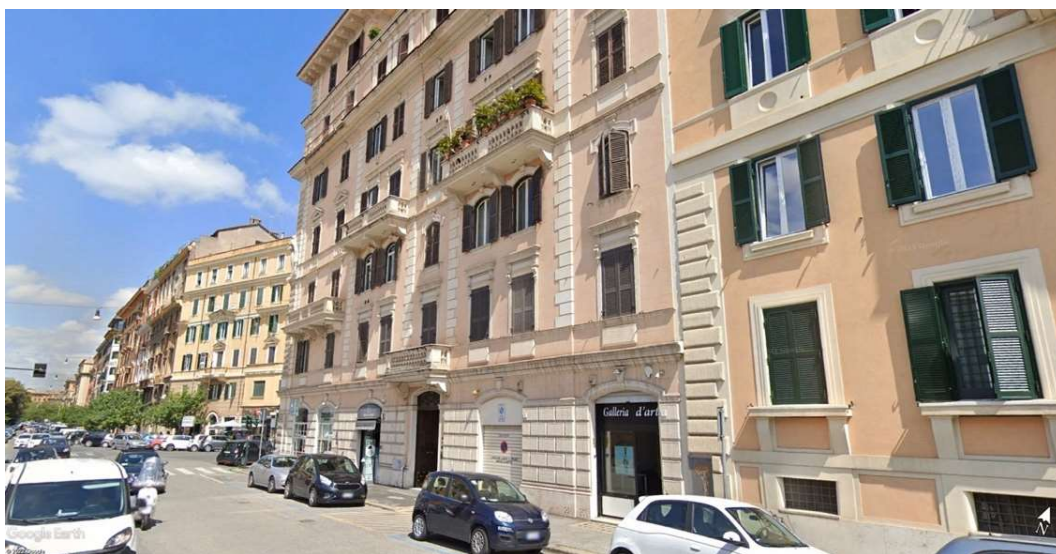
Prospetto del fabbricato su via delle Fosse di Castello – foto 34
