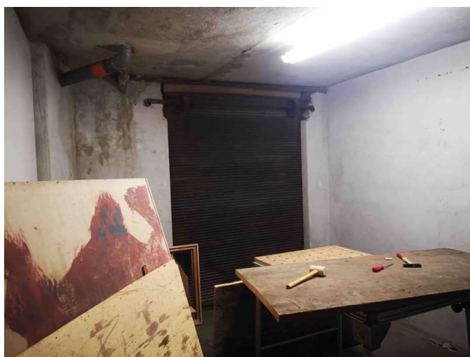
Interno del magazzino – foto 20
