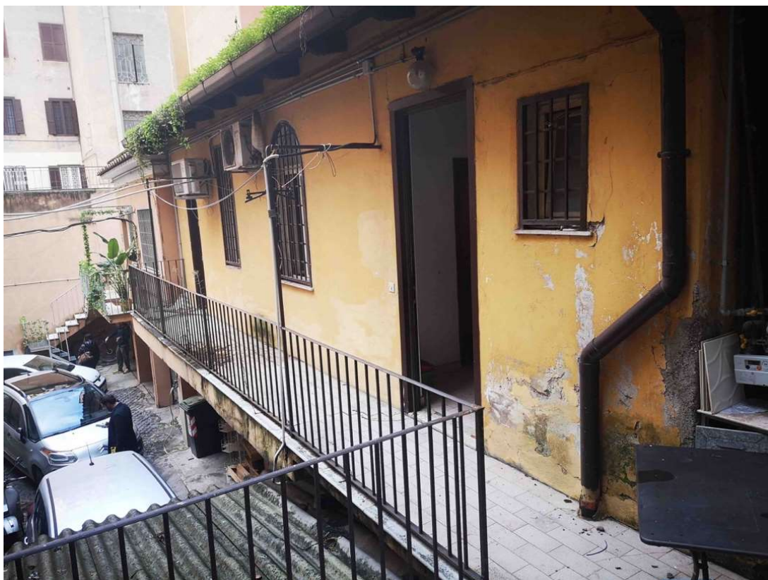
Esterno dell'unità immobiliare – foto 28
