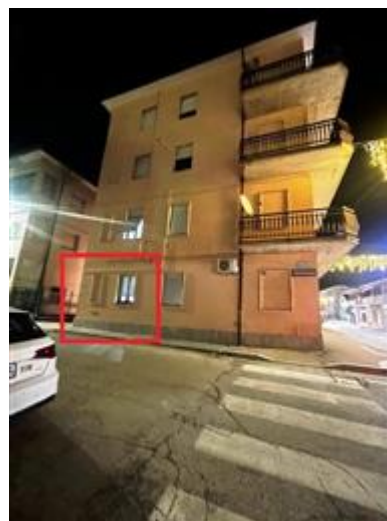
porzione di appartamento su Via Orvieto
