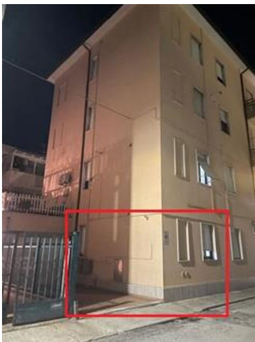
porzione di appartamento su via orvieto
