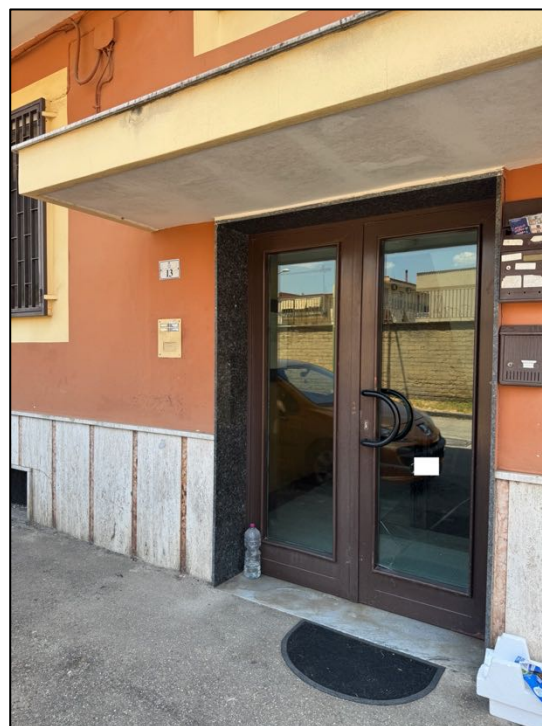
Foto 2 – Accesso androne fabbricato
