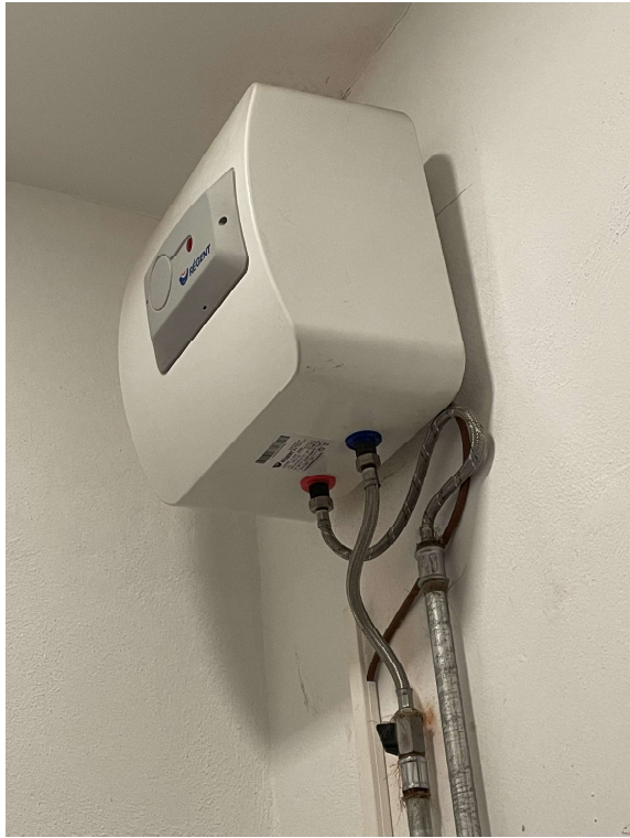
Dettaglio scaldabagno e tubazioni bagno negozio
