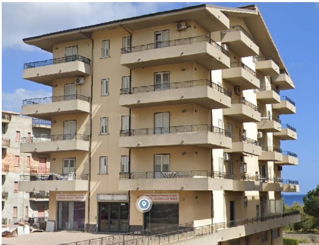
Vista Fabbricato identificato catastalmente al Foglio 45, p.lla 505 - C/da Grotteria Mare n°5 – Comune di Grotteria - il Subalterno 28 si trova al piano secondo Lato Nord.
