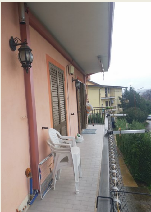
FOTO N° 12 – BALCONE - PIANO PRIMO - FOGLIO 41 - PARTICELLA 315 – SUB 6
