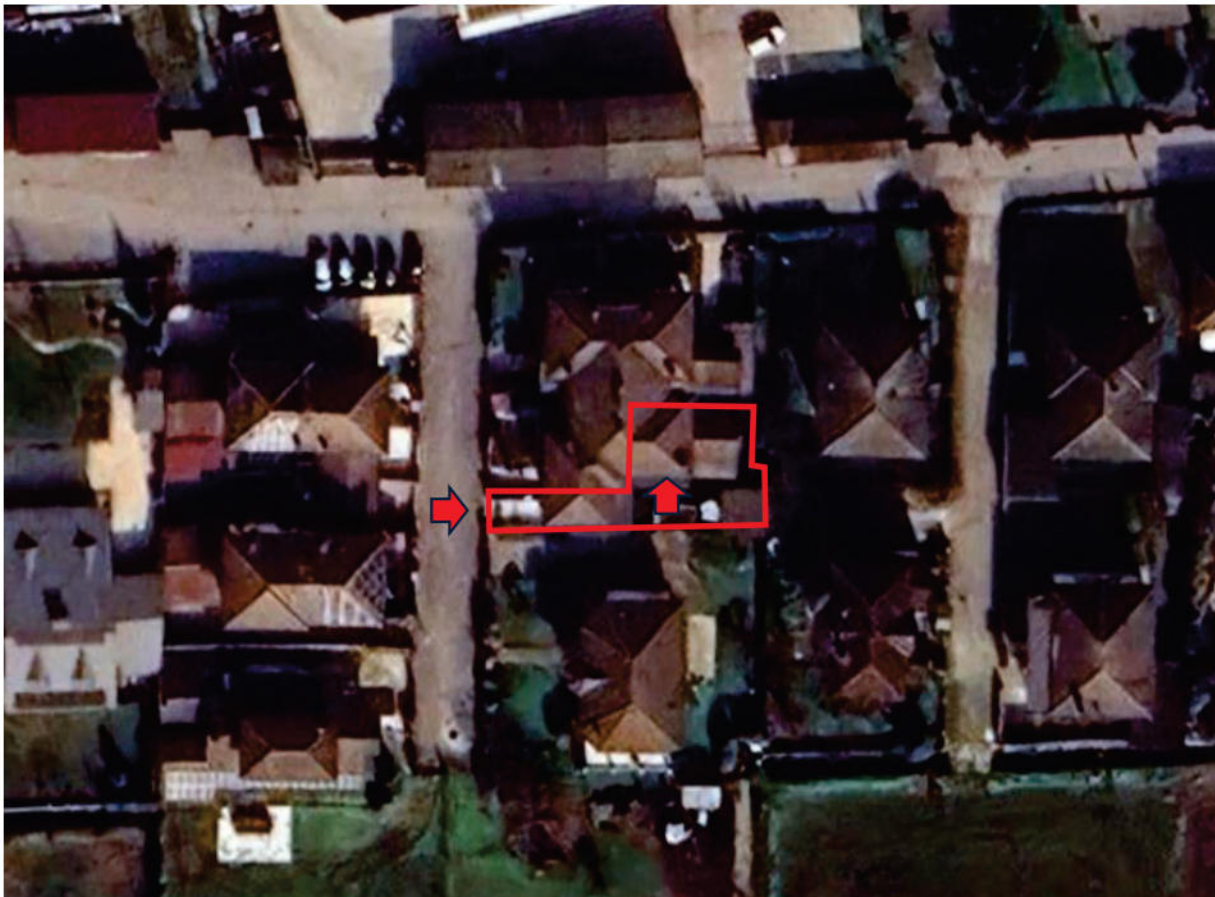
INQUADRAMENTO AEREO: vista d'insieme del lotto e del fabbricato, contornati in rosso.
