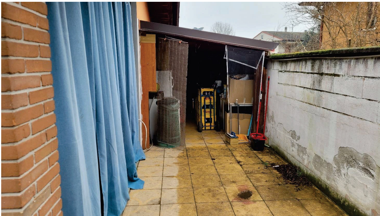
FOTOGRAFIA 7: vista del fabbricato accessorio sul lato est del lotto.
