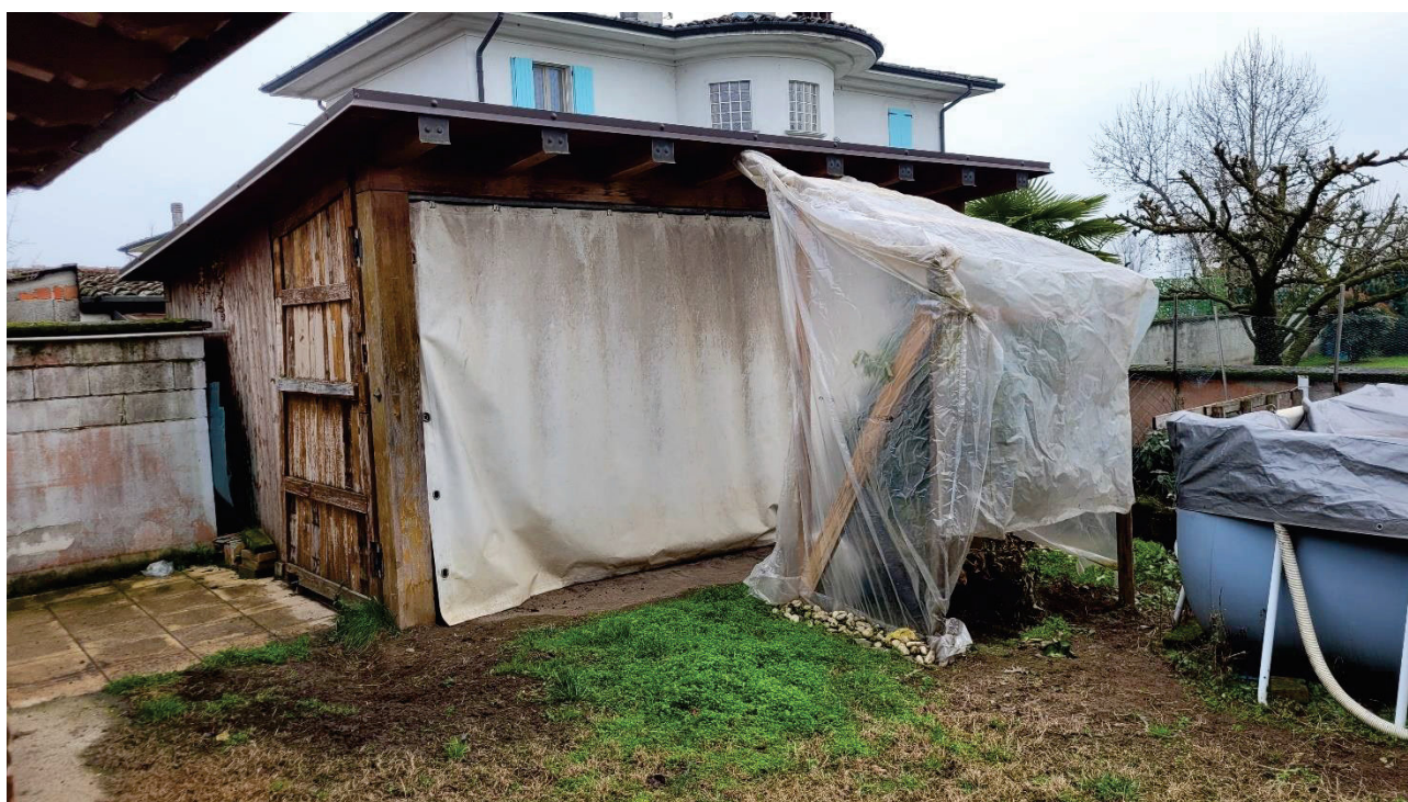
FOTOGRAFIA 4: vista del locale accessorio utilizzato come box.
