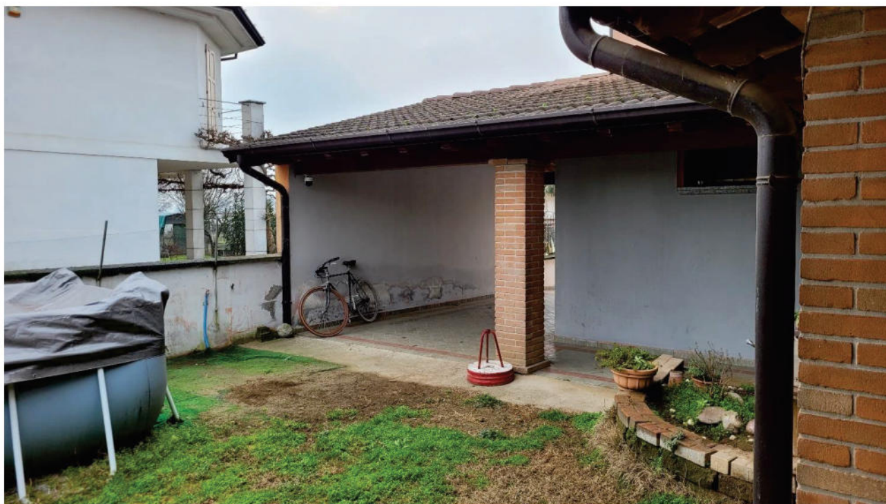
FOTOGRAFIA 2: vista del portico e del posto auto coperto.
