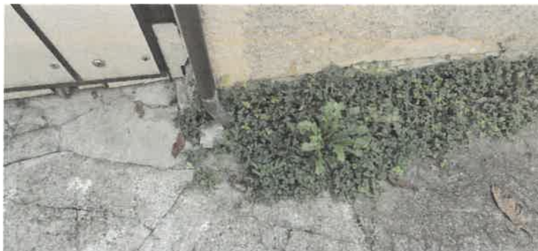
Fotografia 70 – stato conservativo del collettamento acque meteoriche
