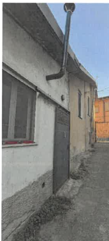
Fotografia 5 – Vista Ovest (canna fumaria sul fronte ovest dismessa successivamente al rilievo fotografico)
