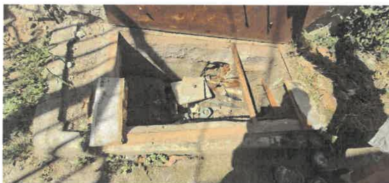
Fotografie 78 e 79 – Nicchia contatore acqua insistente su area esterna privata
