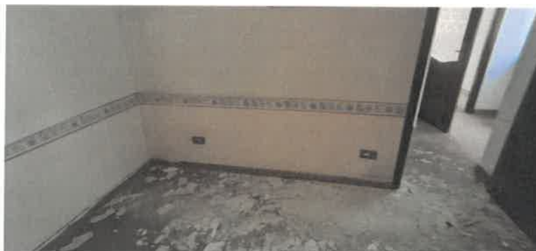
Fotografia 19 – ripostiglio a piano primo adattato a cameretta in violazione del Regolamento Locale di Igiene tipo di Regione Lombardia
