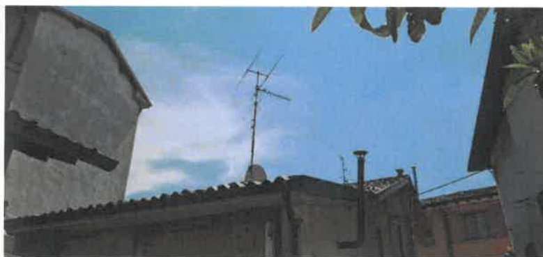
Fotografia 35 – dotazioni impiantistiche – antenna (canna fumaria sul fronte ovest dismessa successivamente al rilievo fotografico)
