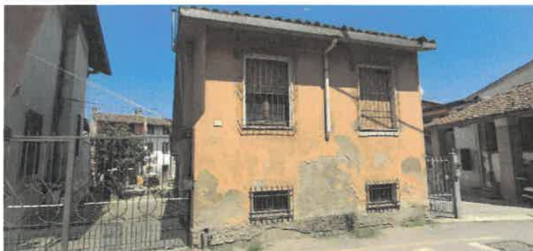
Fotografia 1 – Vista Sud (canna fumaria sul fronte ovest dismessa successivamente al rilievo fotografico)
