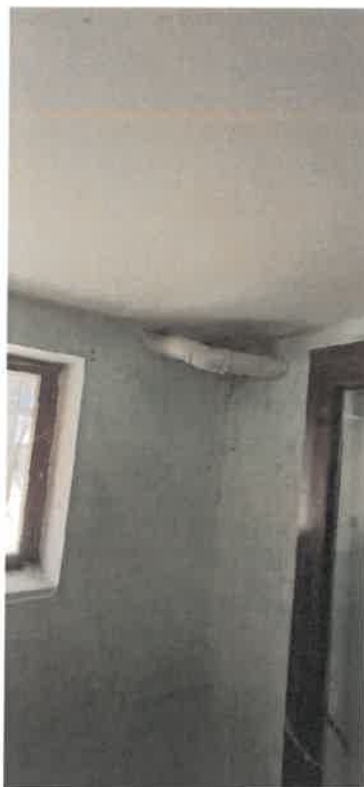
Fotografia 31 – dotazioni impiantistiche a piano terra – ripostiglio
