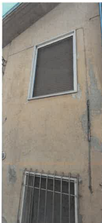
Fotografie 71 e 72 – alimentazione elettrica
