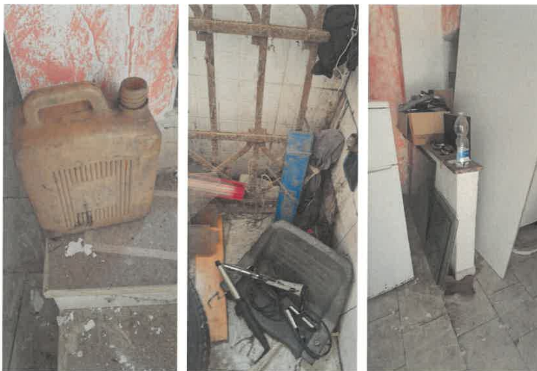
Fotografie 53, 54 e 55 – stoccaggio temporaneo rifiuti a piano terra
