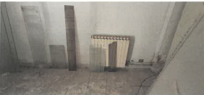
Fotografia 26 – disimpegno a piano terra
