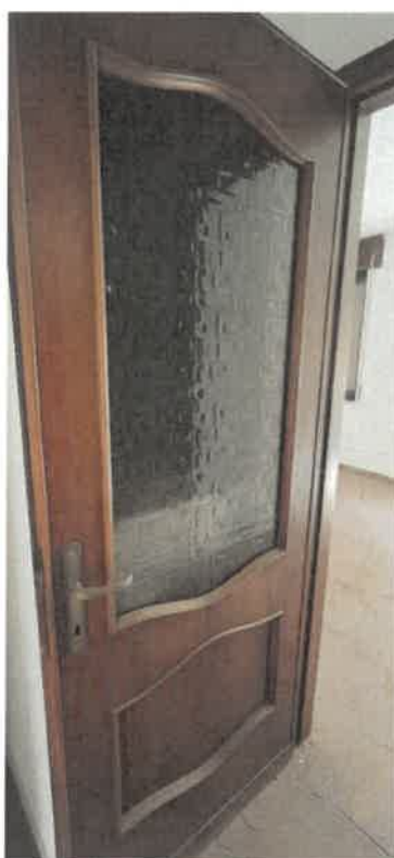
Fotografia 12 – porta da interni camera matrimoniale a piano primo da copertura
