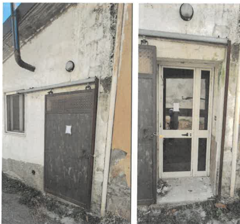
Fotografie 36 e 37 – anta di ferro scorrevole a protezione dell'ingresso principale e porta finestra interna in alluminio
