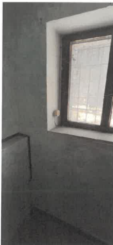
Fotografia 30 – dotazioni impiantistiche a piano terra – ripostiglio
