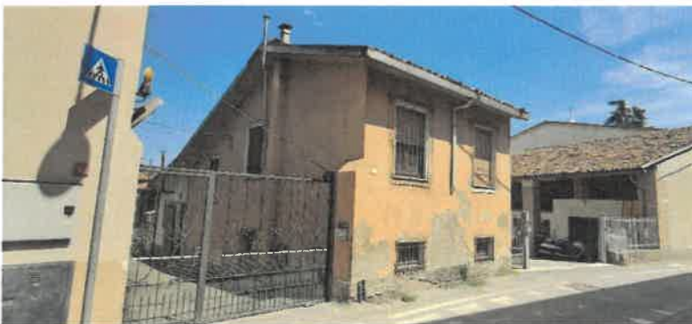
Fotografia 3 – Vista Sud Ovest (canna fumaria sul fronte ovest dismessa successivamente al rilievo fotografico)
